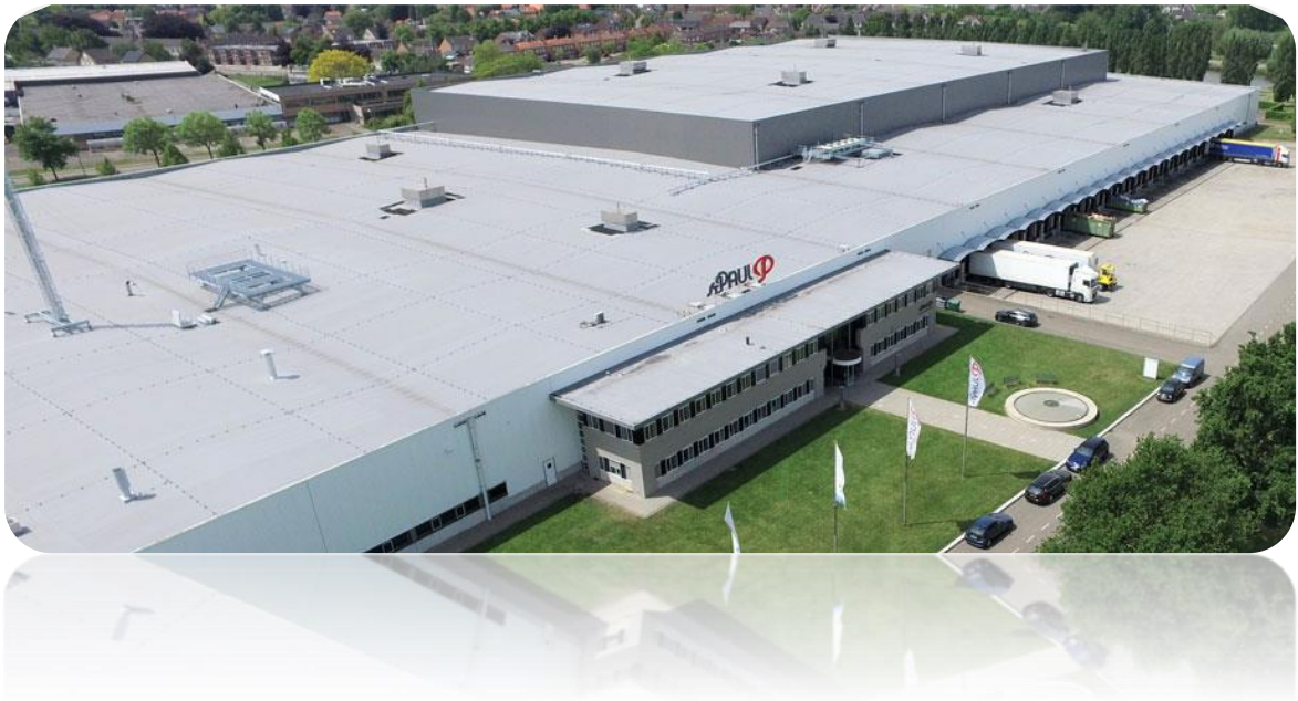
Figuur 10. - technische installaties op het dak
