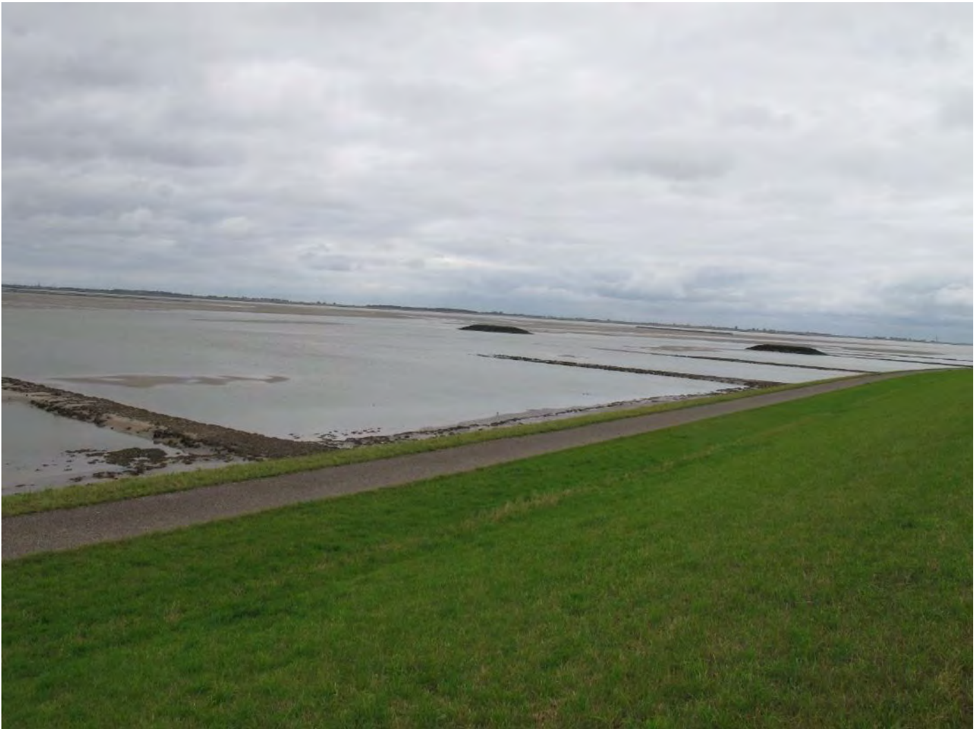
Vlak 29: het groene talud zeewaarts van de inspectieweg (foto in zuidelijke richting). Het lijkt een groene grasmatt, maar is gelegen op de steenglooijing. Vlak loopt door tot de strekdam.
