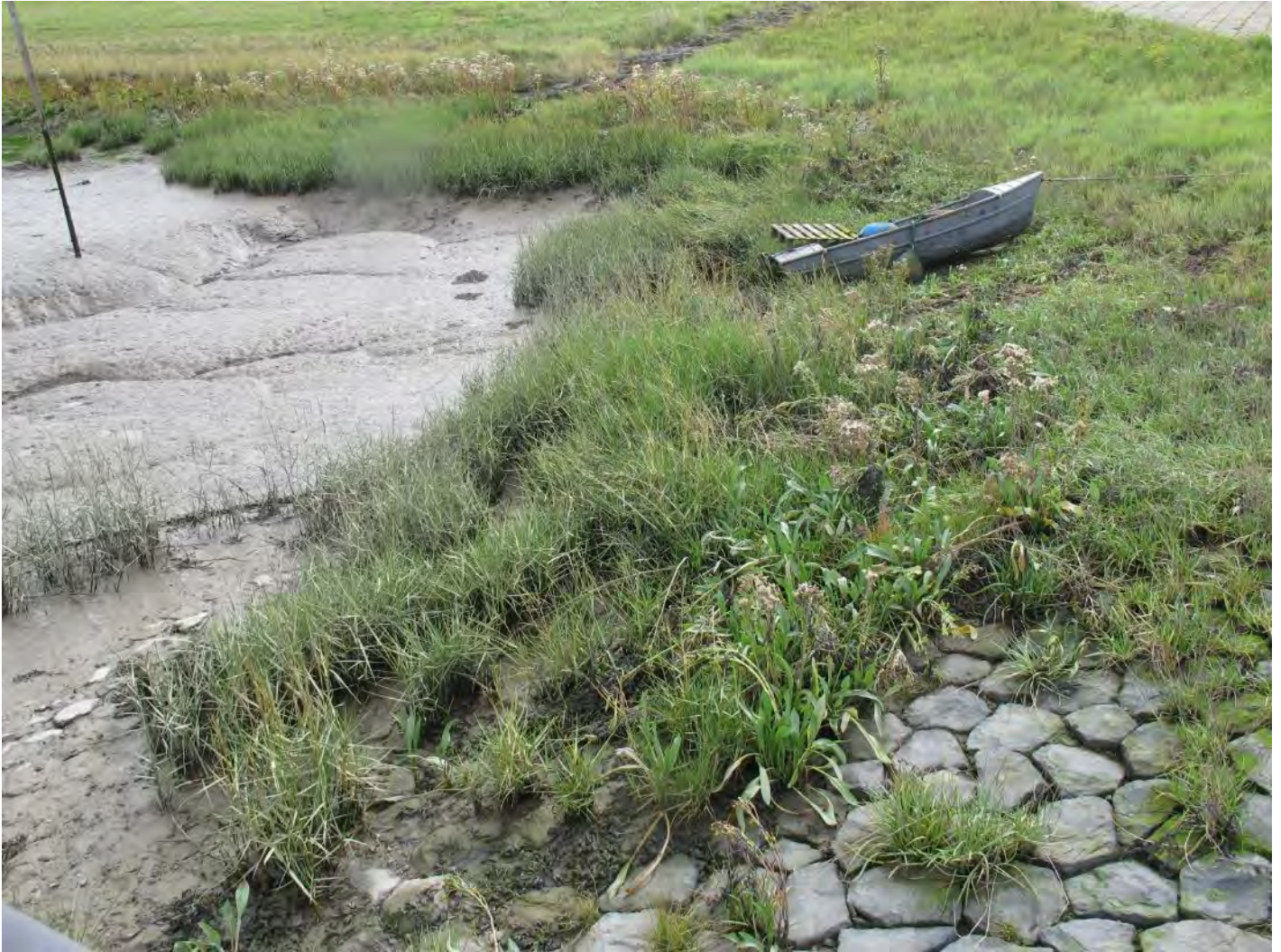
Vlak 7: foto genomen vanaf de strekdam van de haven in zuidelijke richting
