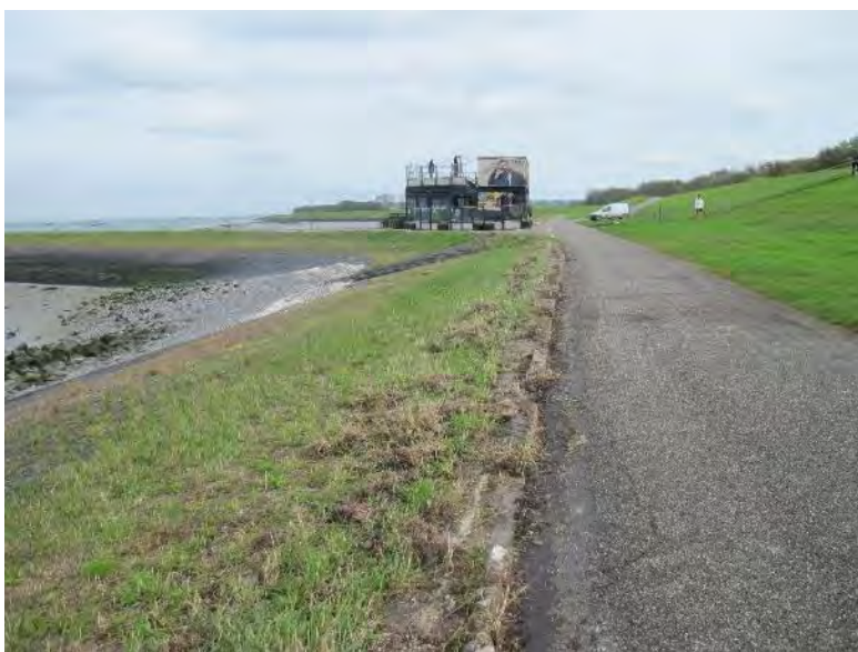
Vlak 6 (west): het groene talud zeewaarts van de inspectieweg (foto in oostelijke richting)
