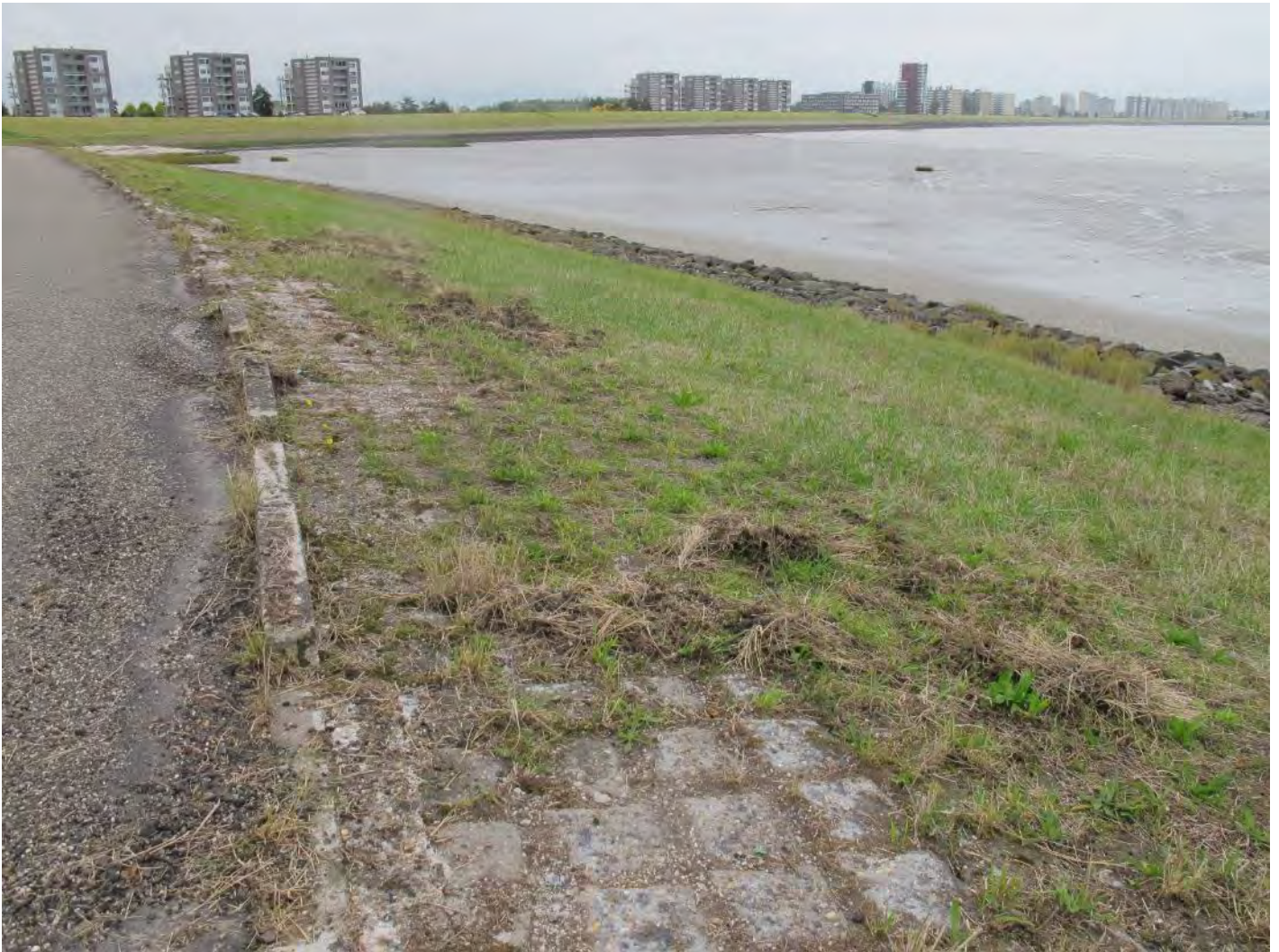
Vlak 3: het groene talud zeewaarts van de inspectieweg (foto in zuidelijke richting). Het lijkt een groene grasmatt, maar is gelegen op de steenglooing. Vlak loopt door tot de strekdam.
