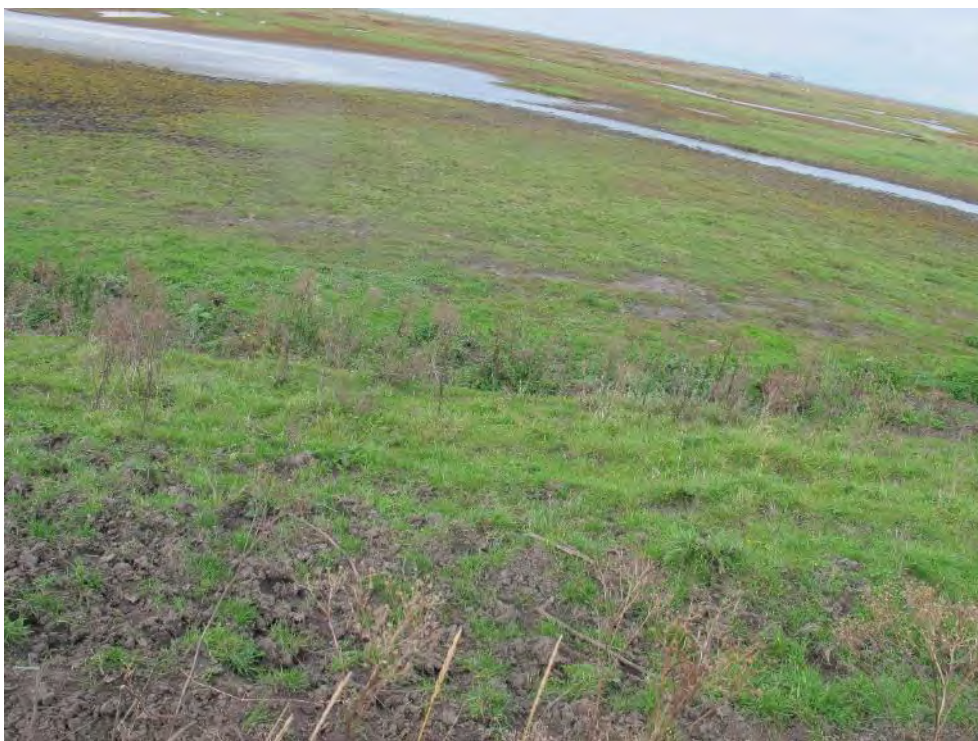
Vlak 43: onder aan het talud staat een hekwerk met veel zoete ruigte (veeklijn)
