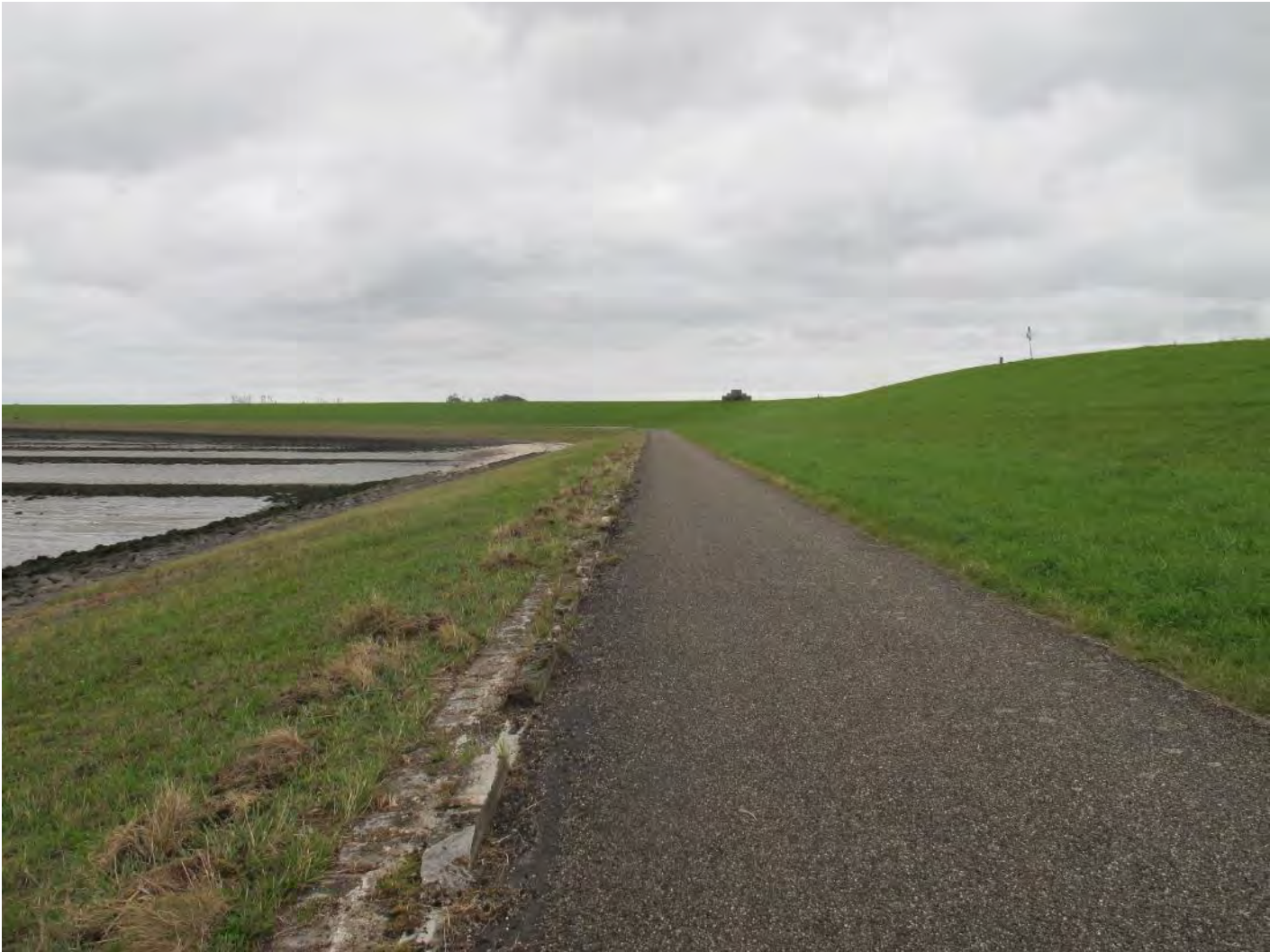
Vlak 5: het groene talud zeewaarts van de inspectieweg (foto in zuidelijke richting). Het lijkt een groene grasmatten, maar is gelegen op de steenglooiing. Vlak loopt door tot de strekdam.
