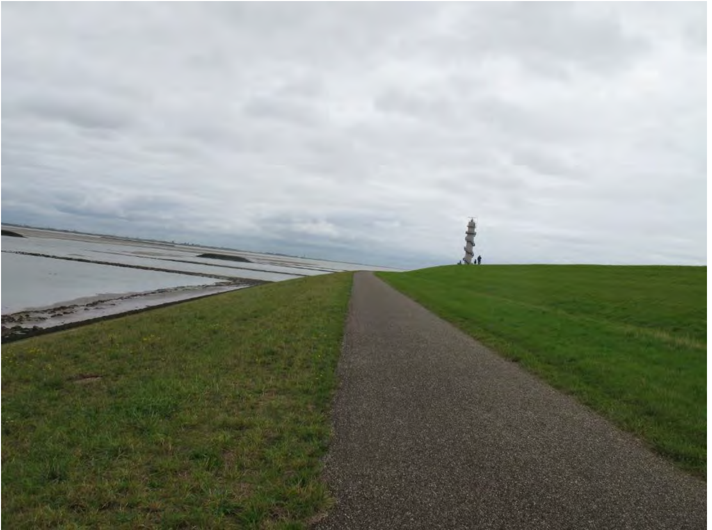
Vlak 30: het groene talud zeewaarts van de inspectieweg (foto in zuidelijke richting). Het lijkt een groene grasmatten, maar is gelegen op de steenglooiing.
