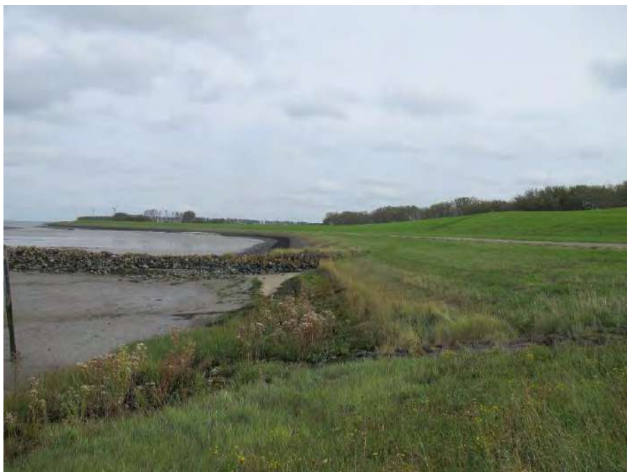
Vlak 6 (oost): de groene vegetatie tussen inspectie pad en laagwaterlijn
