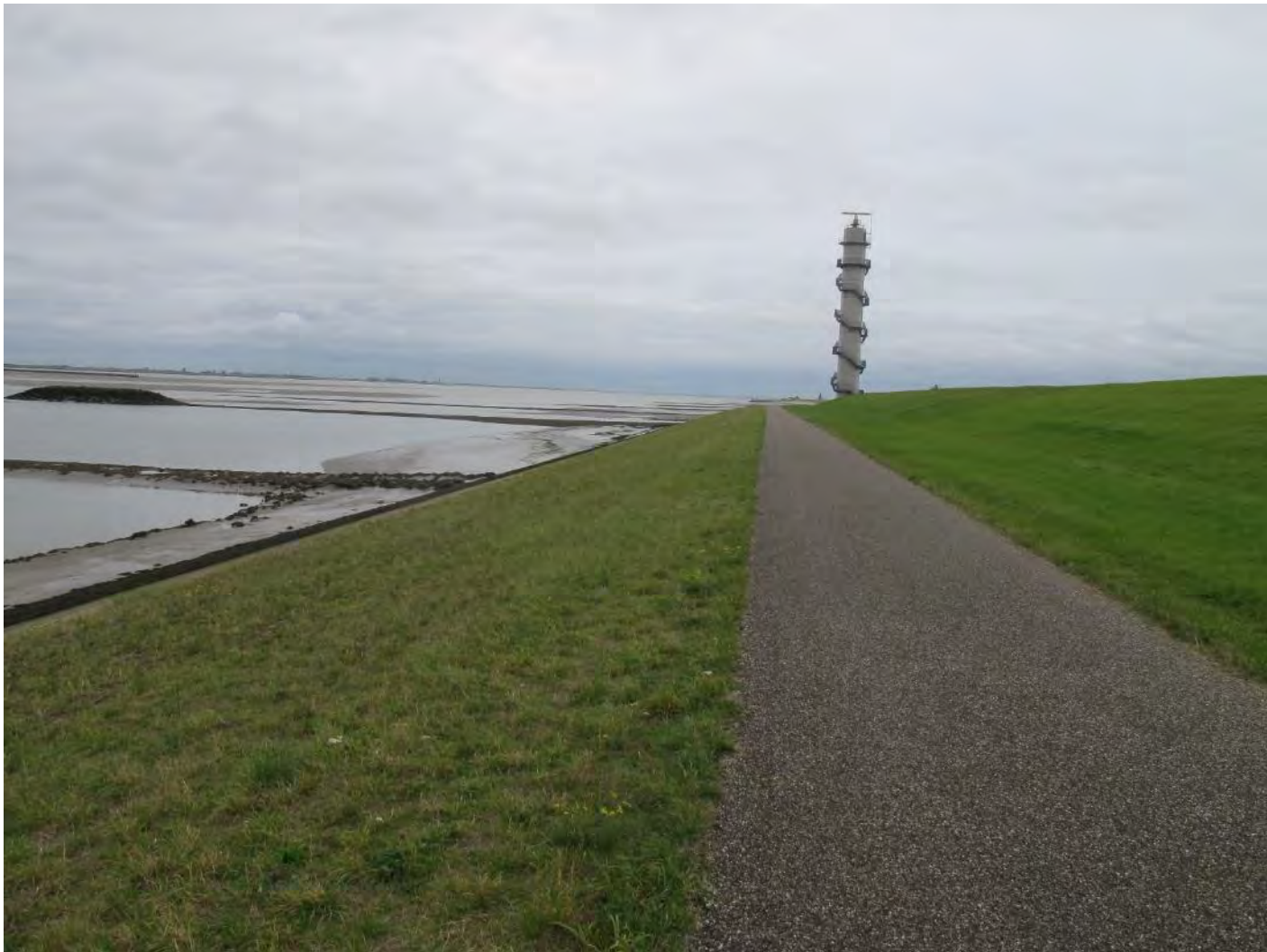
Vlak 31: het groene talud zeewaarts van de inspectieweg (foto in oostelijke richting). Het lijkt een groene grasmatten, maar is gelegen op de steenglooiing.
