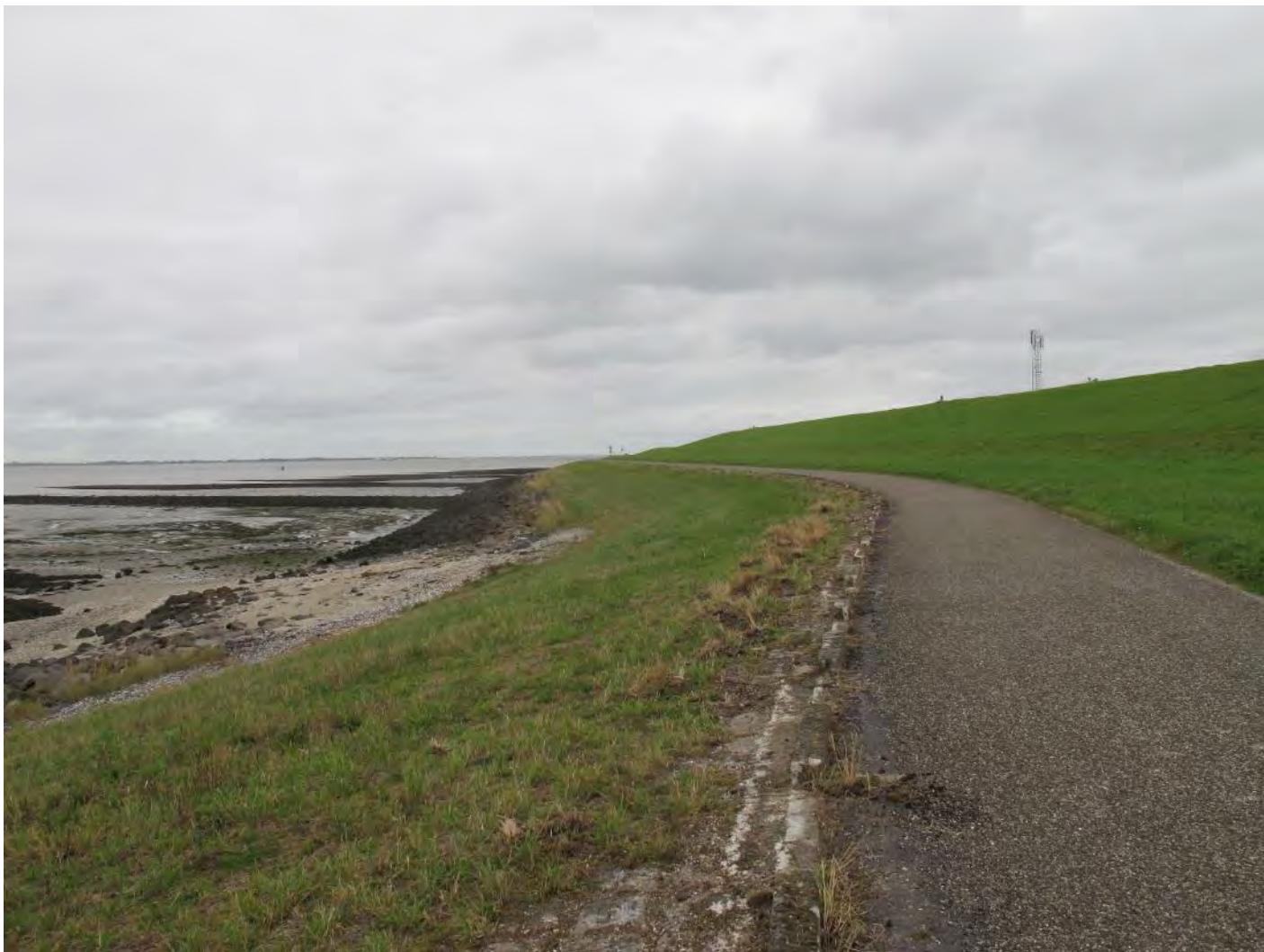
Vlak 4: het groene talud zeewaarts van de inspectieweg (foto in noordelijke richting). Het lijkt een groene grasmatten, maar is gelegen op de steenglooing.
