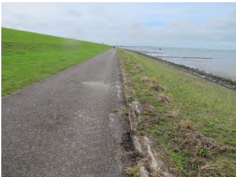
Vlak 6 (west): het groene talud zeewaarts van de inspectieweg (foto in westelijke richting)
