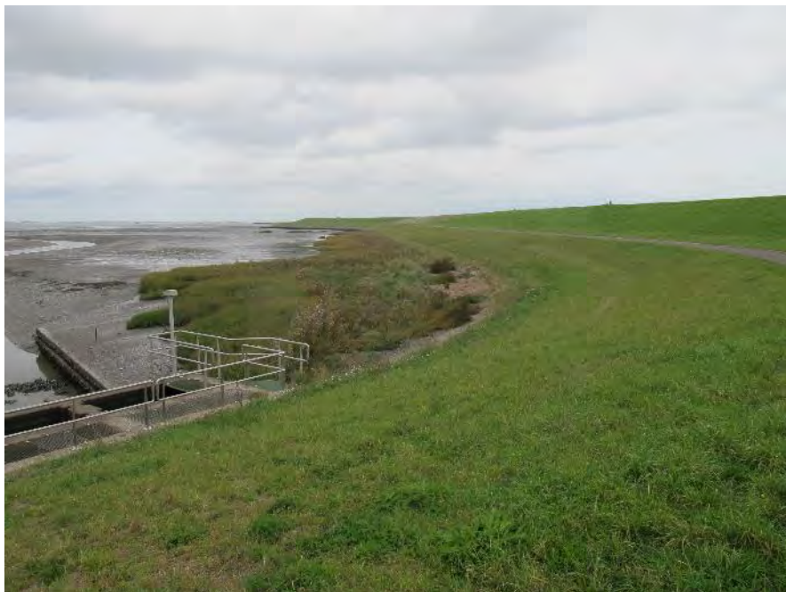
Vlak 12: het groene talud zeewaarts van de inspectieweg (foto in noordelijke richting) vanaf het Gemaal Kampen.
