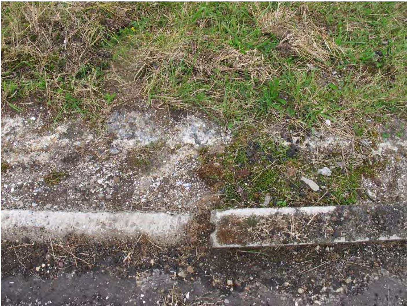
Vlak 2: beeld van de verharding net naast de inspectieweg.
