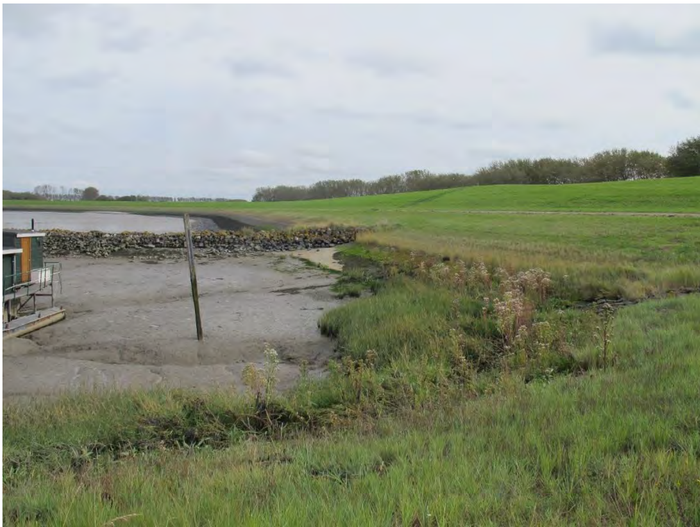
Vlak 7: foto genomen in oostelijke richting
