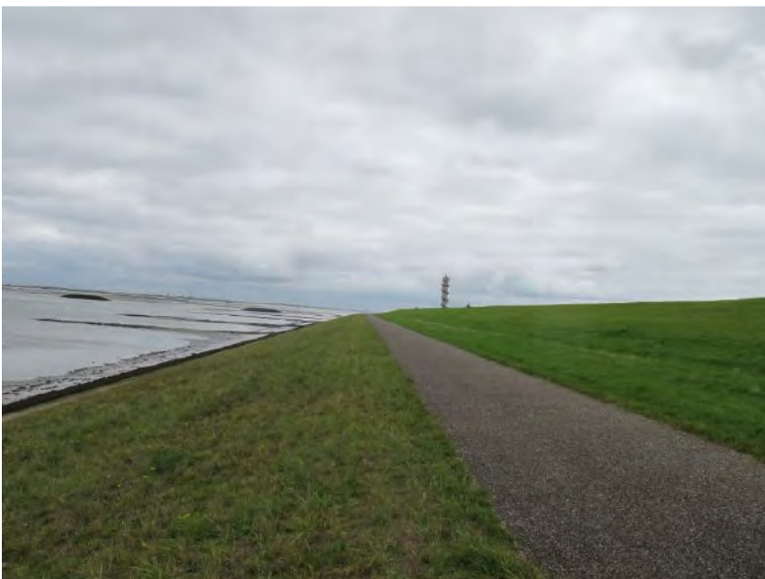
Vlak 28: het groene talud zeewaarts van de inspectieweg (foto in oostelijke richting). Het lijkt een groene grasmatt, maar is gelegen op de steenglooiing.
