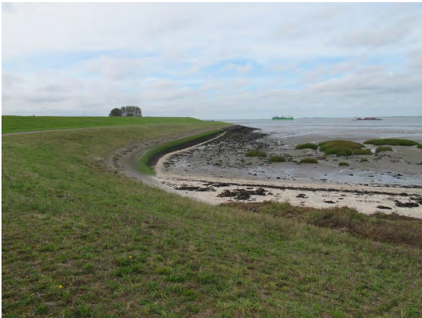
Vlak 8: het groene talud zeewaarts van de inspectieweg (foto in westelijke richting)
