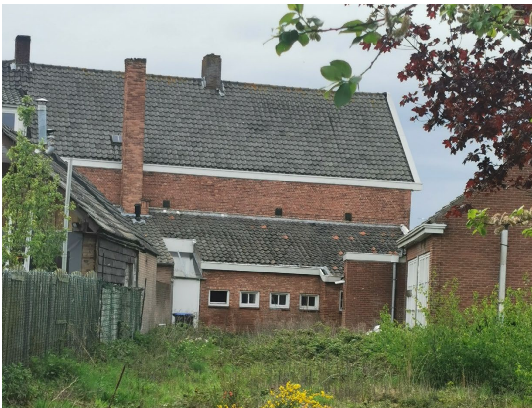
Figuur 6. Bestaande situatie achterzijde
