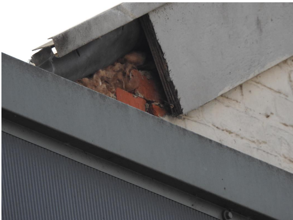
Foto 2. Opening achter gevelbeplating.
