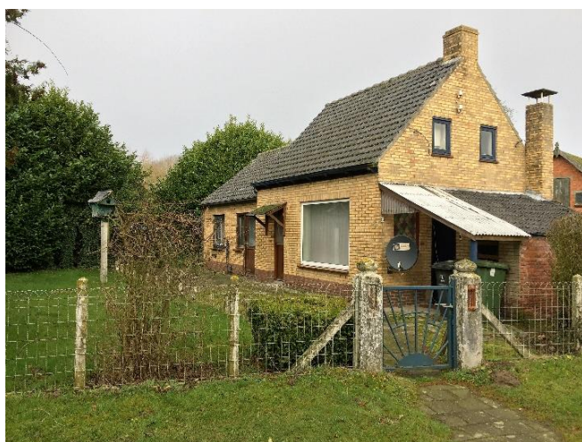
Figuur 1 | Bestaande woning Zoutestraat 105 (bron: eigen opname)
