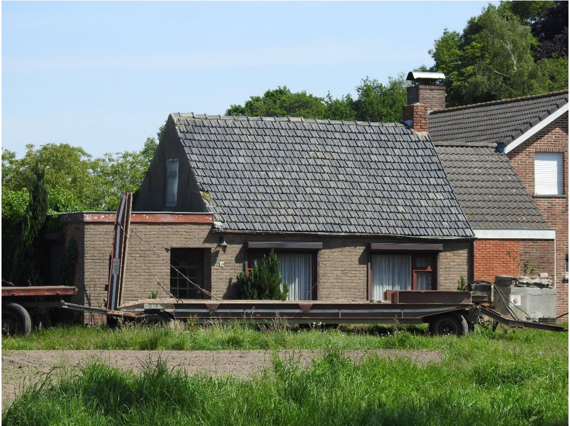
Foto 1. Te slopen bebouwing.
