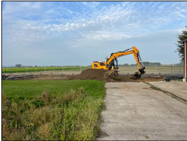
Foto 2: Start bodemsanering op 2 oktober 2023
