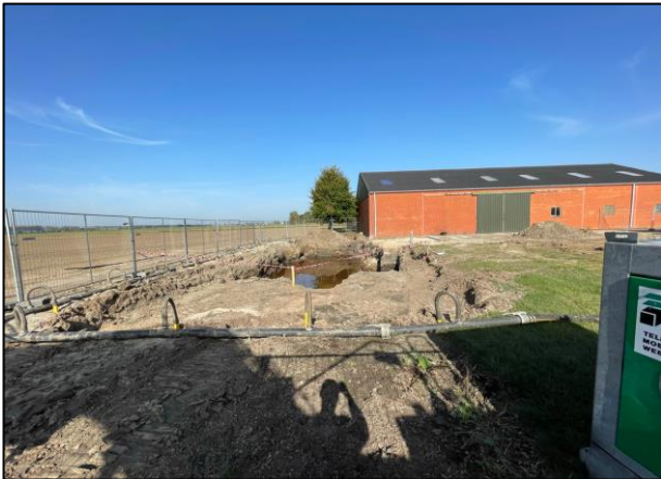
Foto 3: Situatie op 10 oktober 2023 Gezien vanaf het zuiden in noordelijke richting
