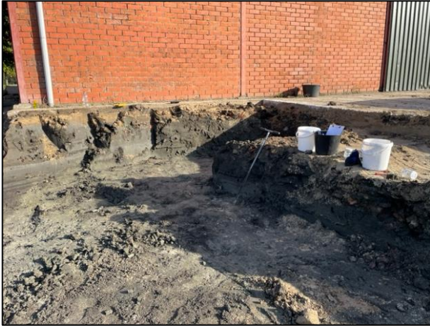
Foto 6: putwand MW12 en MW13
