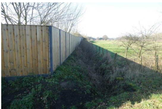
Zicht vanaf de noordoosthoek op de schutting aan de noordzijde.
