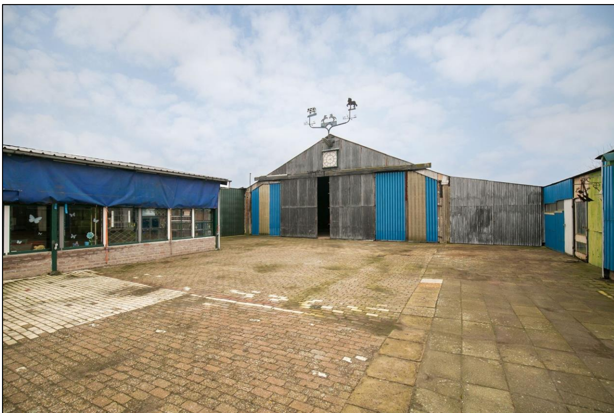
figuur 2.3 Deel van de te slopen agrarische bebouwing.
