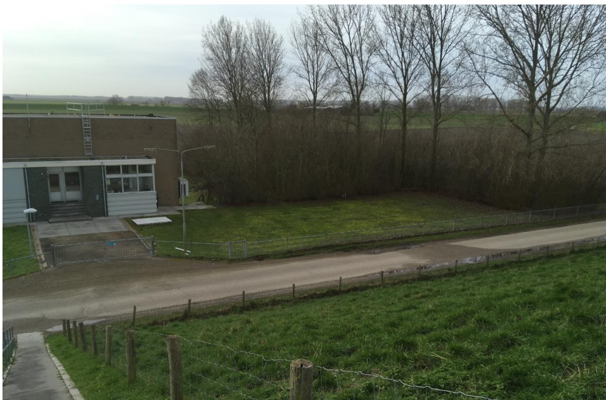
Foto 2: Aanzicht bestaand gemaal vanaf de waterkering.
