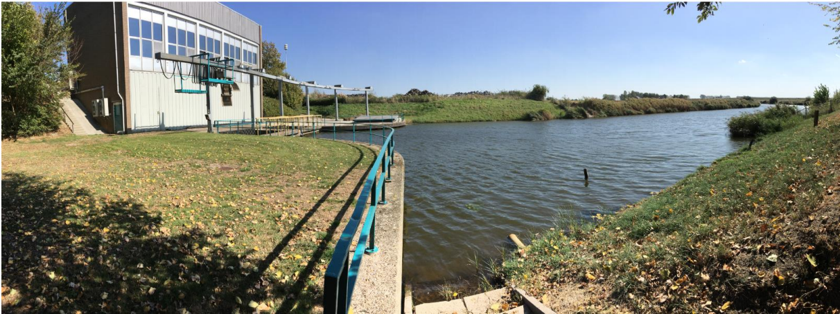
Foto 3: Polderzijde van het gemaal, met instroomconstructie en maalkom.
