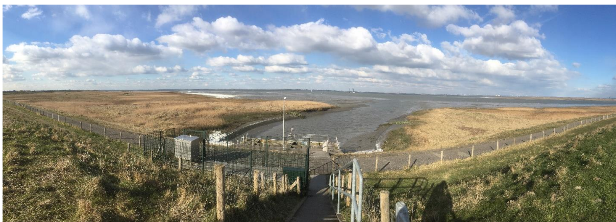
Figuur 3-3. Het schor bij de uitstroom van gemaal Paal.
