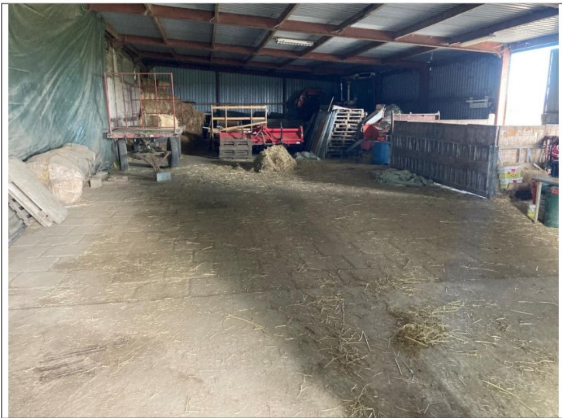
Foto 7: binnen de overkapping van de schuur
