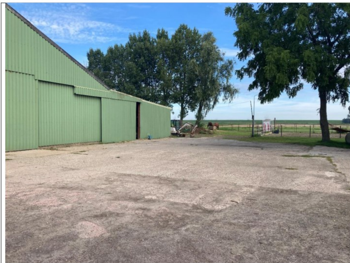
Foto 3: schuur met overkapping en erf
