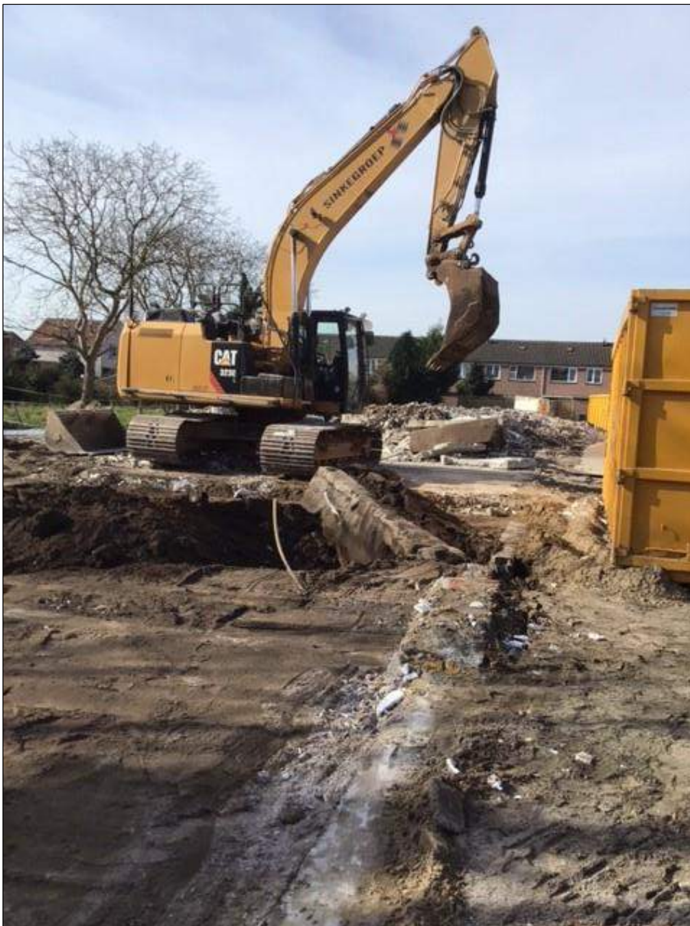
Figuur 20 Foto van de sloopwerkzaamheden, waarbij tevens de fundering van de woningen al is verwijderd. Bron: opdrachtgever.
