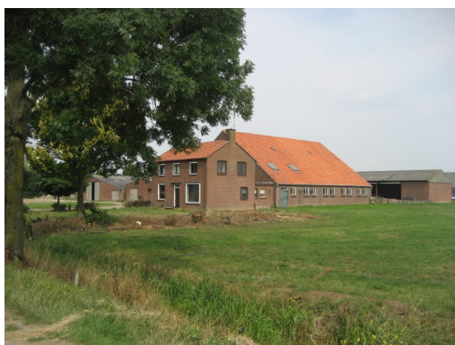
Huidige bebouwing, te behouden
