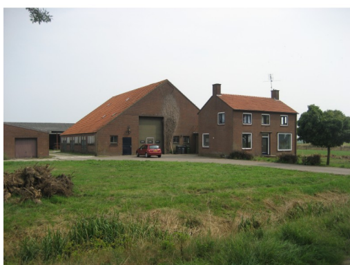
Huidige bebouwing, te behouden
