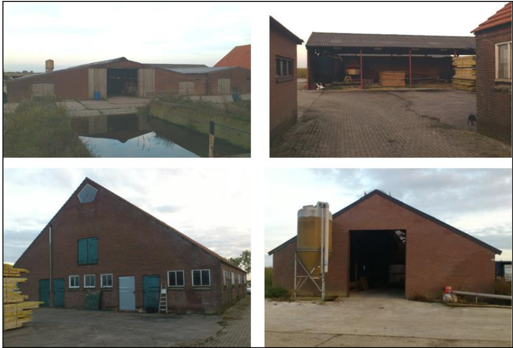
Bedrijfsgebouwen in het plangebied
