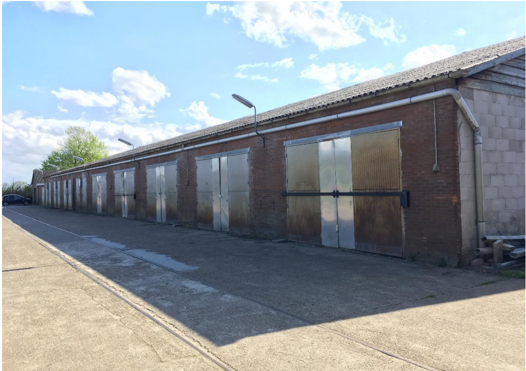
Figuur 3 De schuur is centraal op de westzijde van het perceel gesitueerd. De loods is aan de noordzijde gesitueerd. Op de oostelijk gelegen akker na, is het perceel volledig verhard.
