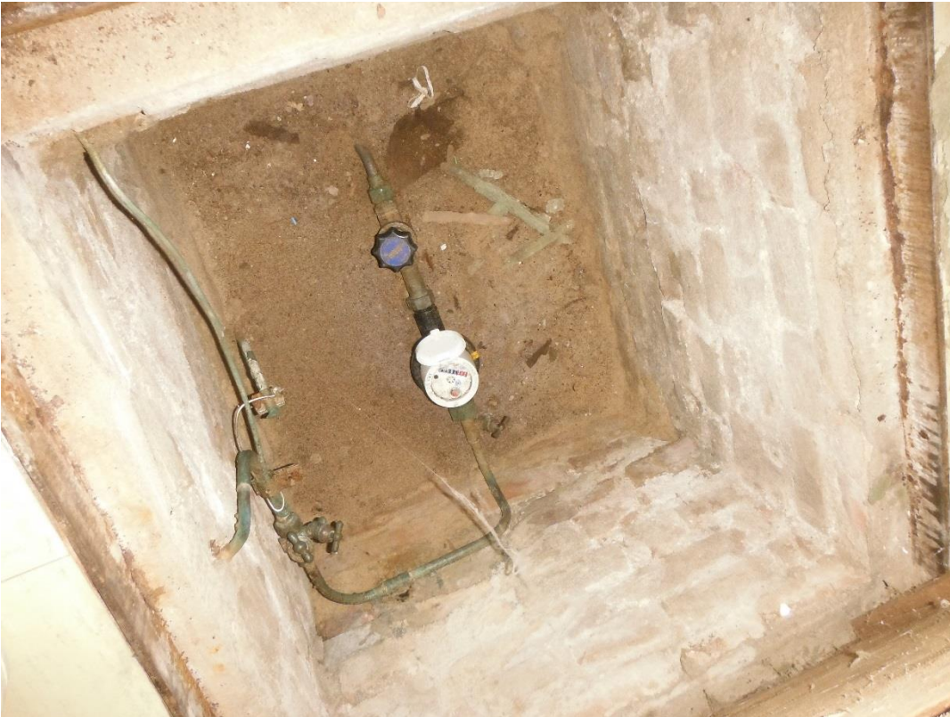
Geen asbestverdachte toepassingen in de watermeterput aangetroffen
