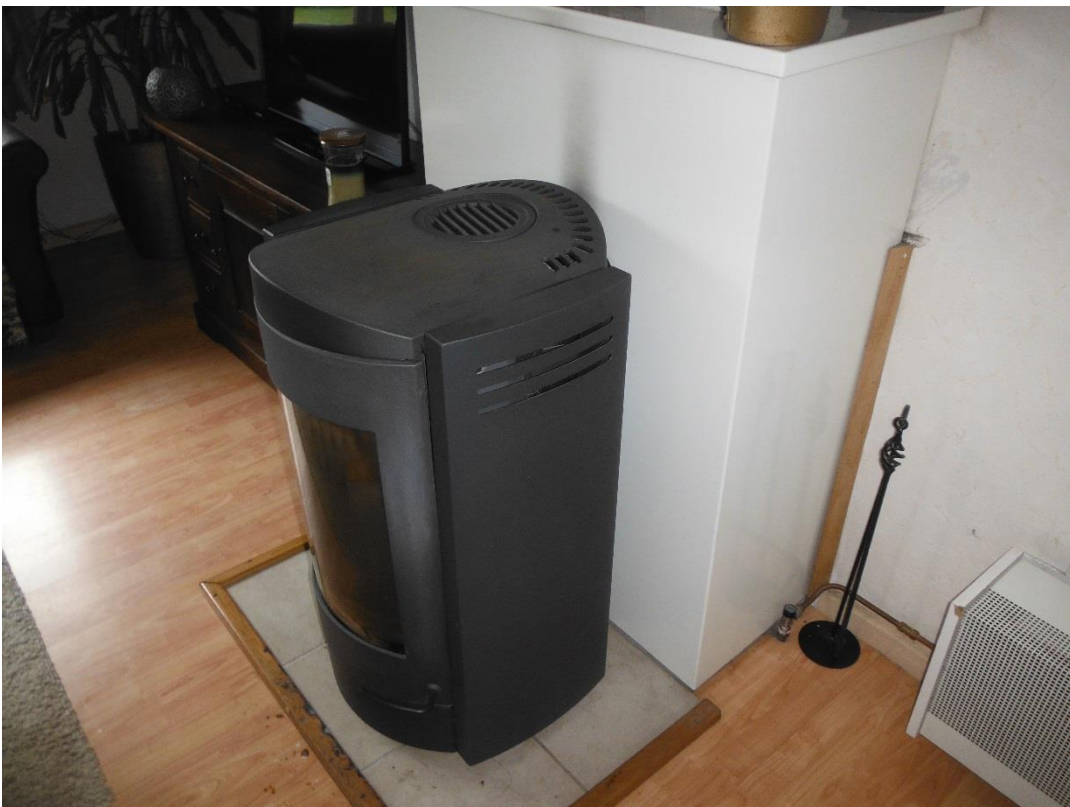
Houtkachel en metalen schouw NIET asbestverdacht
