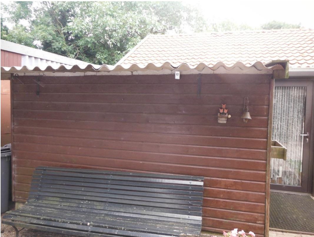
Golfplaten op berging NIET asbestverdacht
