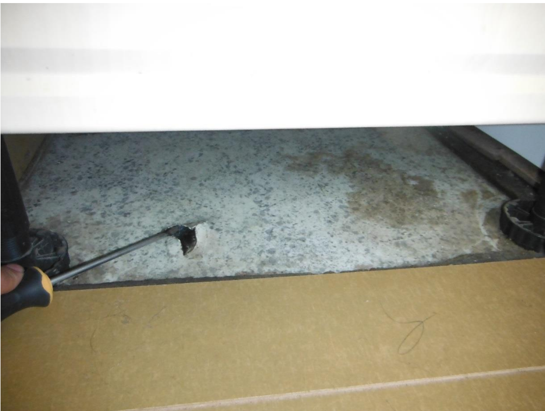
Vloerzeil onder keukenblok NIET asbestverdacht
