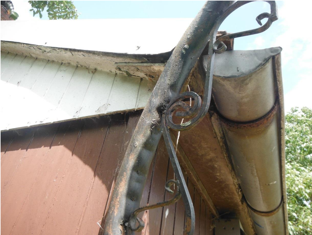
Houten gootaftrimmering
