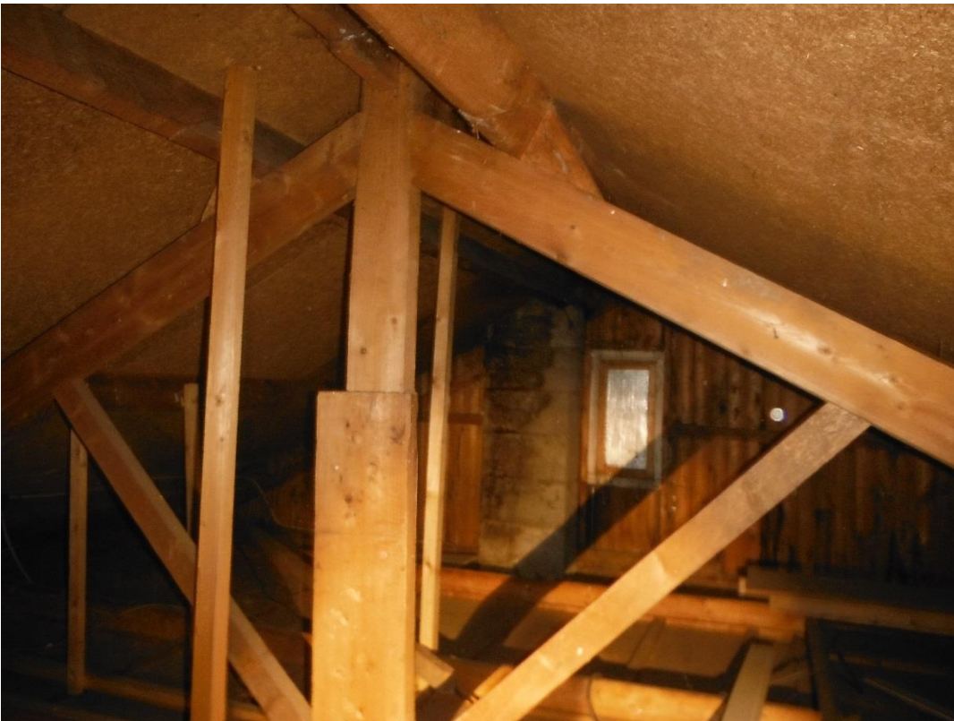
Gemetseld schoorsteenkanaal op zolder
