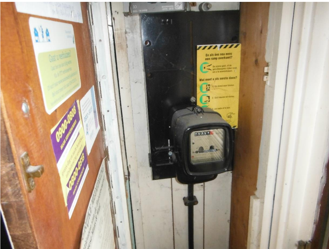
GEEN asbestverdachte toepassingen in meterkast aangetroffen
