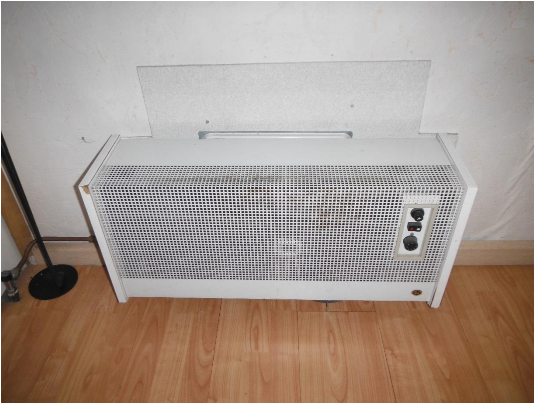
Gevelkachel en plaatmateriaal NIET asbestverdacht
