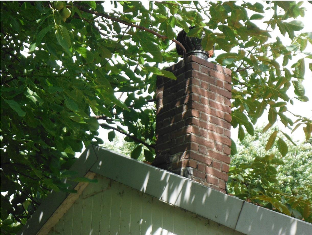
Rookgasafvoer NIET asbestverdacht
