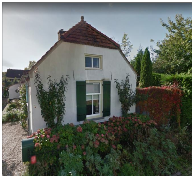
Gemeentelijk monument Lakenstraat 73 (Bron: Google Maps)
