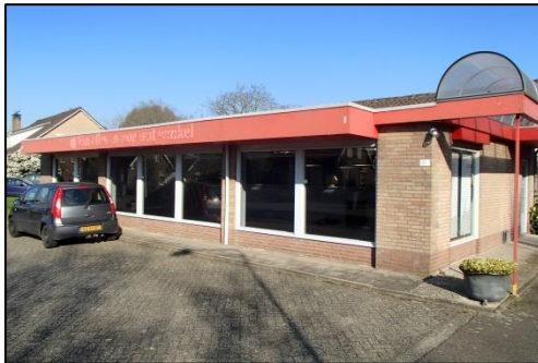
Plangebied vanuit het zuidoosten.
