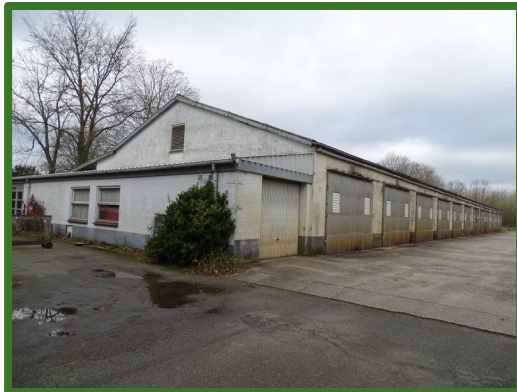
Afbeelding 5: Bedrijfsloods vanaf het zuidoosten
