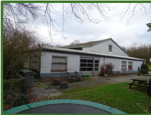
Afbeelding 6: Bedrijfsloods vanaf het zuidwesten
