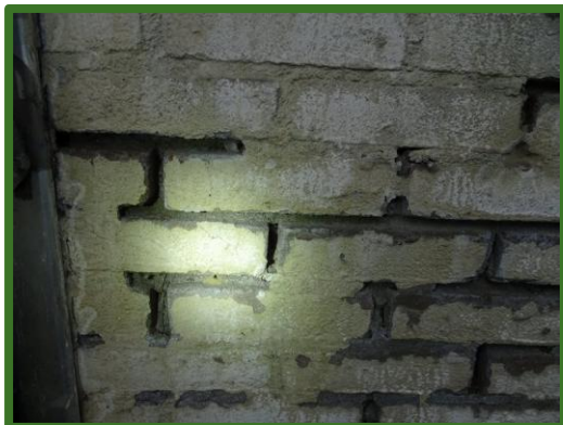
Afbeelding 21: Ontbrekende voegen
