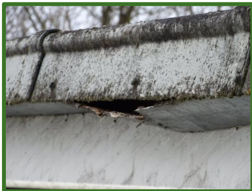
Afbeelding 19: Gat in het boeiboord van de bedrijfsloods
