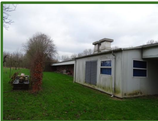
Afbeelding 8: Bedrijfsloods vanaf het zuidwesten
