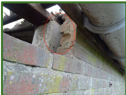
Afbeelding 23: Opening tussen muren van de stal
