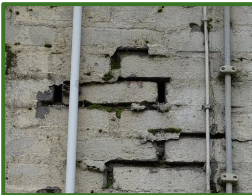
Afbeelding 20: Ontbrekende voegen, directe toegang tot de spouwmuur
