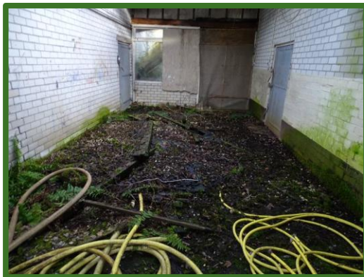
Afbeelding 13: Binnenzijde bedrijfsloods ten noorden
