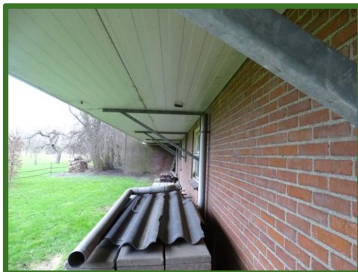
Afbeelding 7: Bedrijfsloods vanaf het zuidwesten
