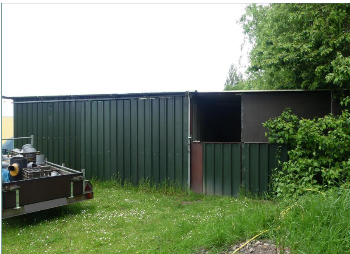
Figuur 2 In de beoogde ruimtelijke ingreep wordt de paardenstal gesloopt.
