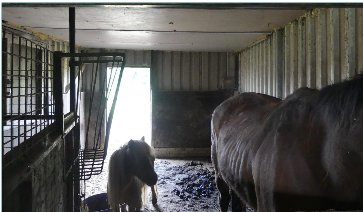
Figuur 3.1 In de paardenstal zijn de openingen gedicht met purschuim. Tevens zijn in de paardenstal geen wegkruipruimten aanwezig die kunnen dienen als nestlocatie voor de huismus of gierzwaluw.
