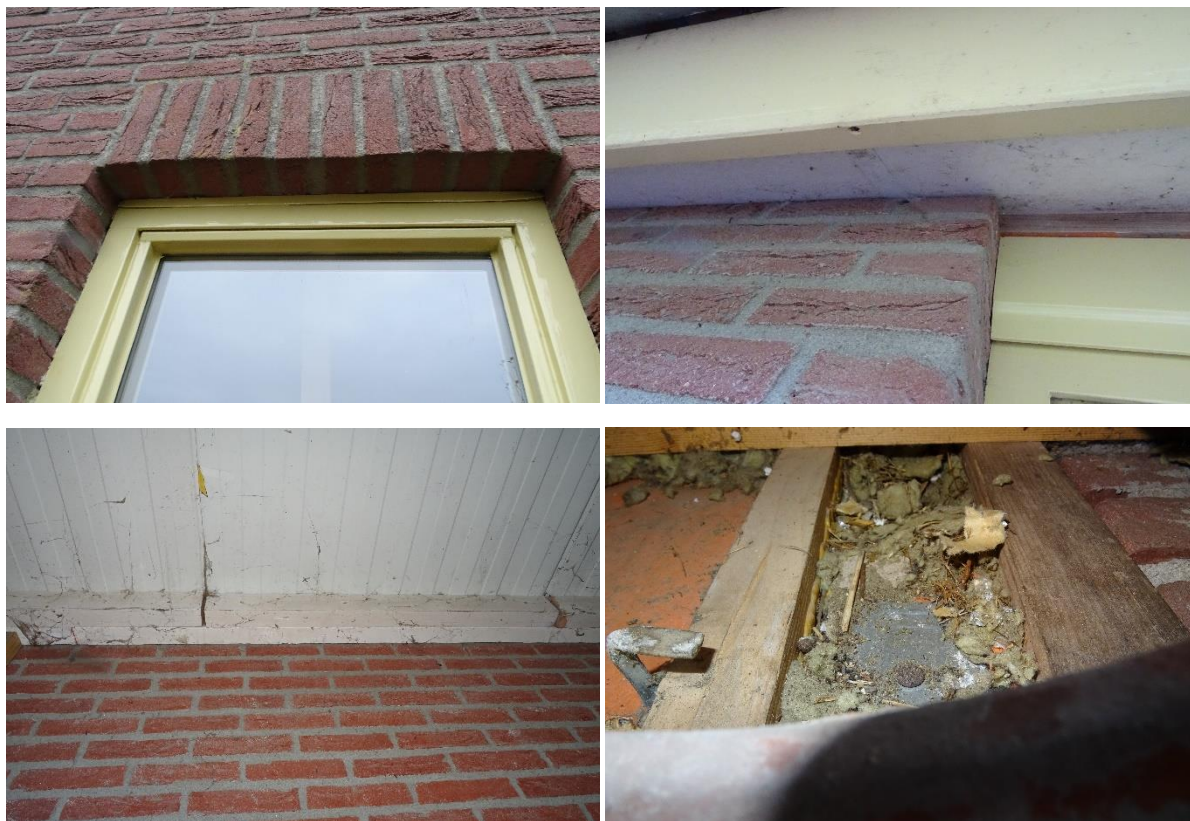
Afbeelding 10 t/m 14: geen mogelijke verblijfplaatsen van vleermuizen bij overstekken en kozijnen, ook is de bovenzijde van de spouwmuur afgesloten (afb. 14): Bron: BNL advies. Datum: 11-11-2021
