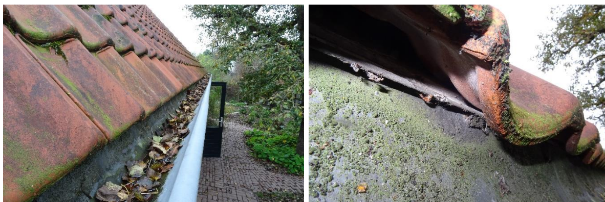
Afbeelding 8 en 9: daken met sandwichpanelen en bedekt met dakpannen. Bron: BNL advies. Datum: 11-11-2021
