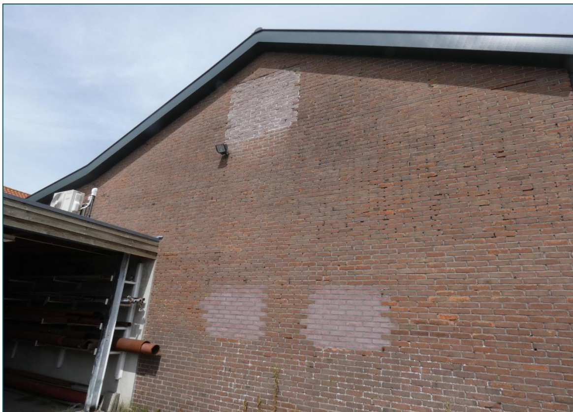
Figuur 2 De bebouwing bestaat uit gemetselde muren zonder spouw en is voorzien van een golfplaten dak.
