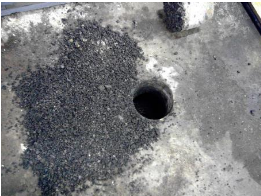
Gravel onder betonverharding uit boorgat 01
