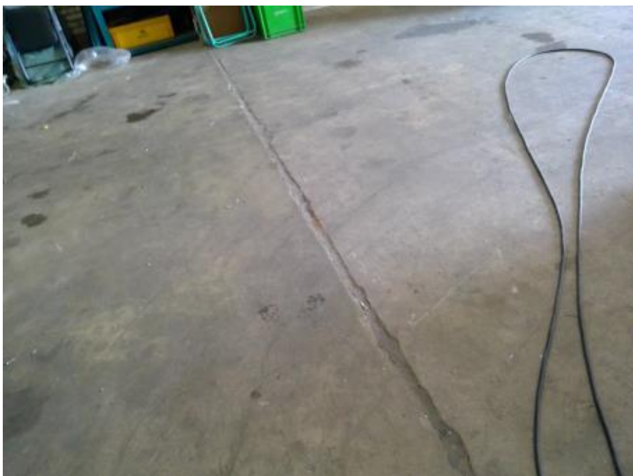
Foto 6: dicht gekitte voegen in werkplaats
