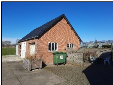
Figuur 3. Zijaanzicht van de schuur (kijkrichting vanuit het oosten).
