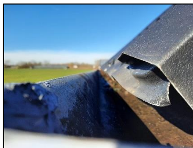
Figuur 7. Dakgoot langs de zuidelijke kant van de schuur.
