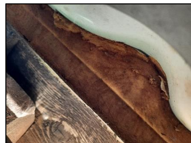
Figuur 8. Zicht onder het dak van de schuur.
