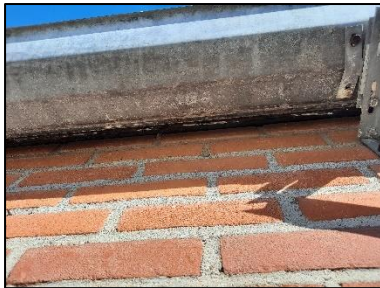
Figuur 9. Onderkant van de dakgoot nauwsluitend op de zijgevel van de schuur.
