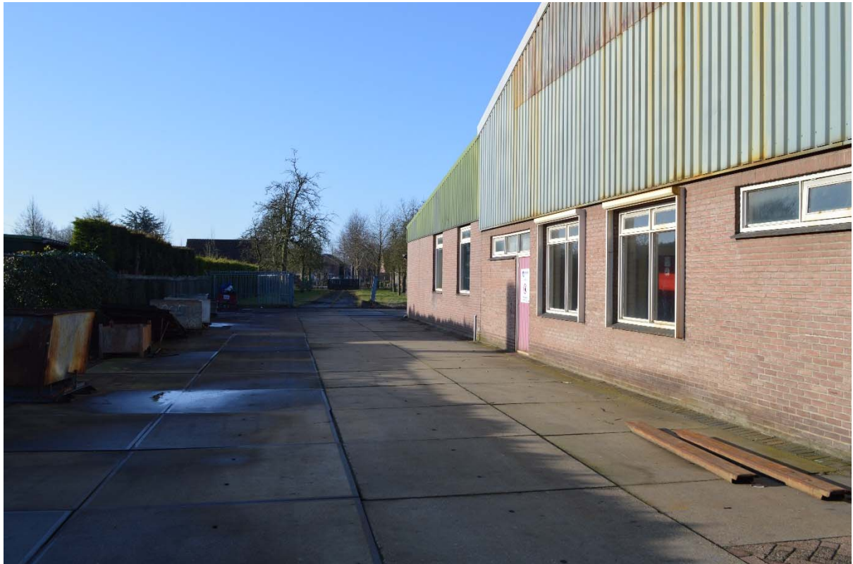
Ten oosten van verzinkerij met links de dieseltank en OBA
