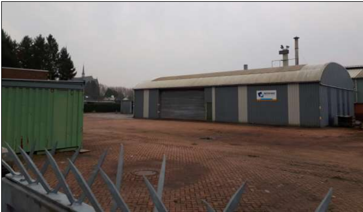
Figuur 8: Niet meer in gebruik zijnde bebouwing en verhard terrein van de Verzinkerij Dreumel B.V. in het centrale deel van het plangebied, kijkende vanaf de Industrieweg in zuidoostelijke richting, richting de Barbarakerk die zichtbaar is op de achtergrond (maart 2018).
