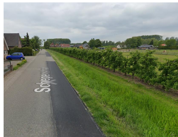
Figuur 4-1: Huidige breedte C-watgang met beperkte afvoercapaciteit
