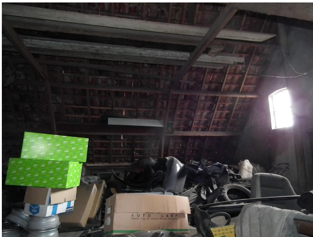
Figuur 2 Het dak van de schuur is dermate open en niet afgewerkt dat er geen openingen of holtes voor vleermuizen en geen geschikte nestlocaties voor huismus aanwezig zijn.
