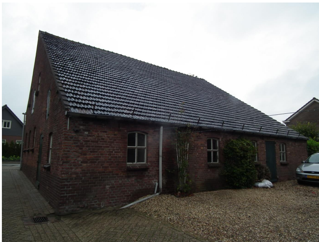
Figuur 1 De projectlocatie is gelegen aan de Dorpstraat 34 te Dreumel. De initiatiefnemer is voornemens de bestaande schuur te slopen ten behoeve van 2 woningen.
