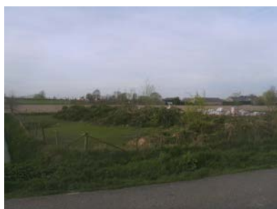
Foto 1: Onderzoekslocatie gezien in noordwestelijke richting met het aanwezige gronddepot en de bouwmaterialen
