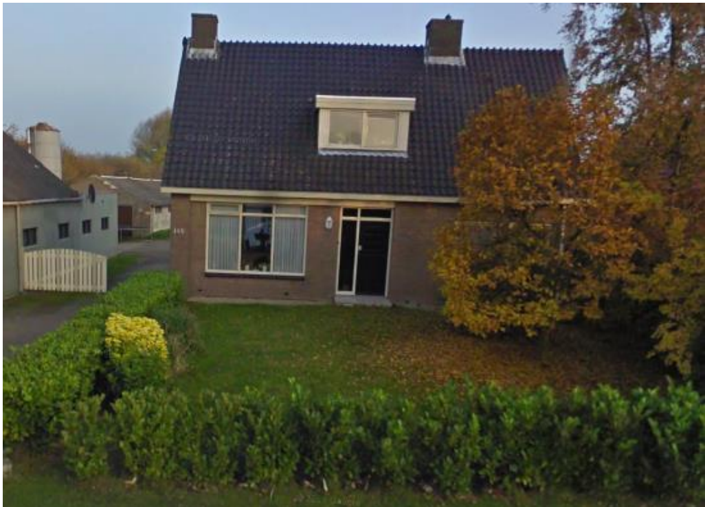
Woning met op achtergrond de voormalige agrarische bebouwing in het plangebied (bron: Google Maps, oktober 2009)
