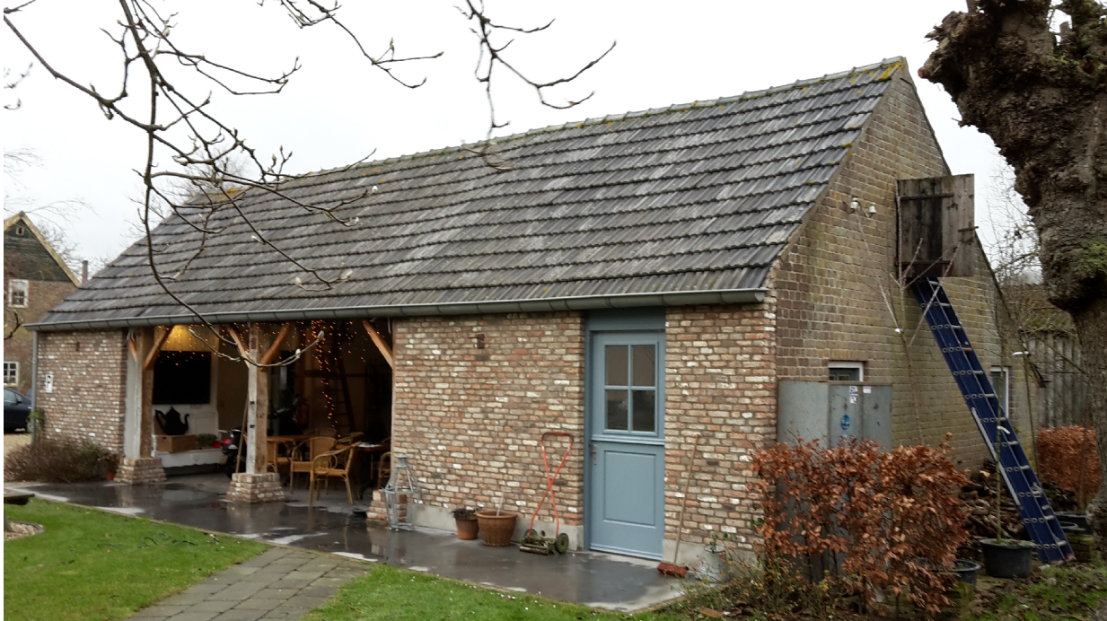
Foto's bestaande schuur. d.d. 02-01-2017 Buitenzijde blijft ongewijzigd
