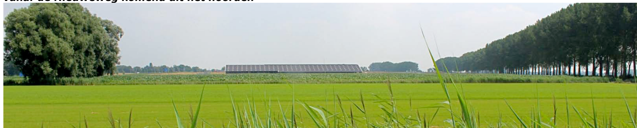
vanaf de Nieuweweg, komend uit het zuiden
