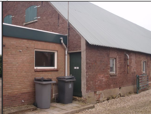
Aansluiting melkveeststal en tussengebouw
