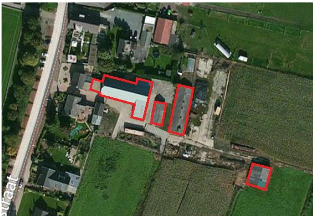
Luchtfoto plangebied met te slopen bebouwing
