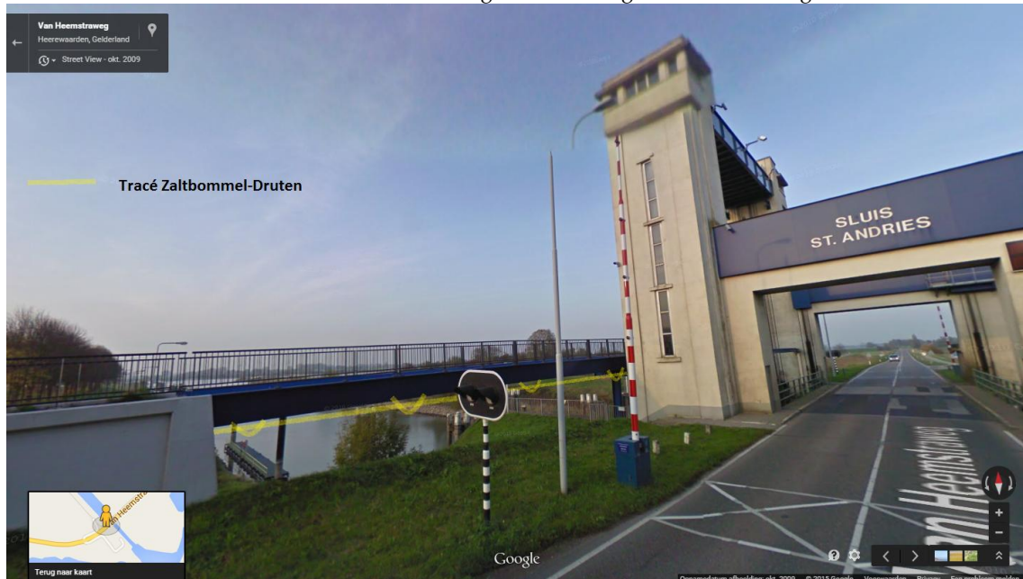
Figuur 10: Bovengrondse kabelophanging onder fietsbrug.
