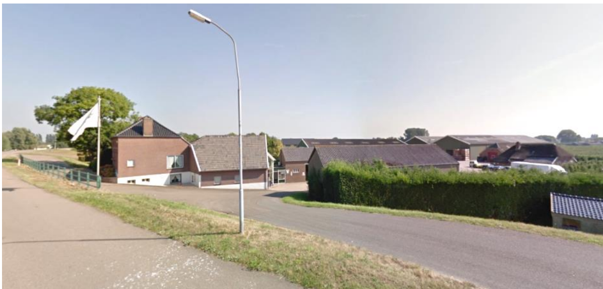
Waaldijk 2a en 3 met bedrijfsbebouwing (bron: Google Maps, september 2016)
