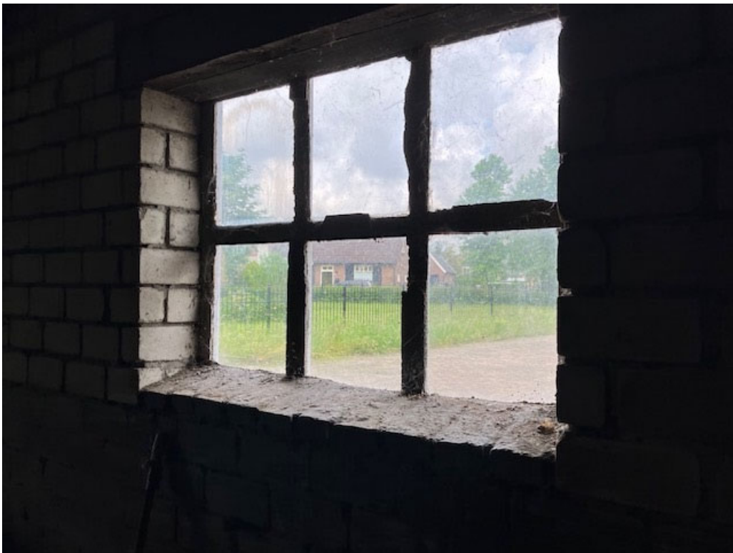
• Afbeelding 16: Detail gevel schuur, steens muur
