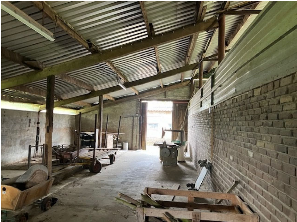
• Afbeelding 13: Binnenzijde voormalige stal
