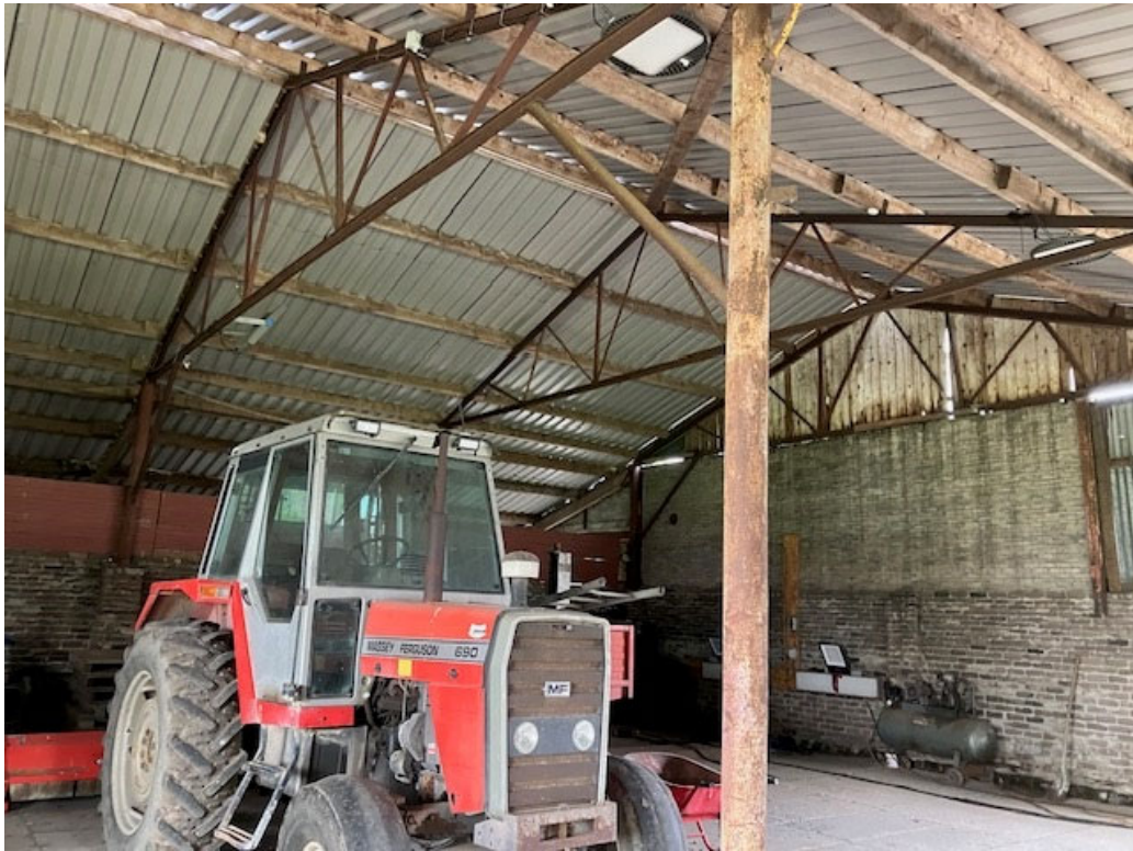
• Afbeelding 11: onderzijde schuur
