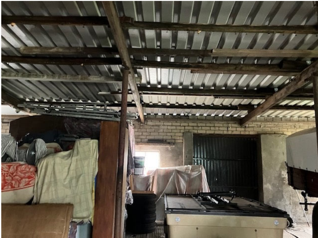
• Afbeelding 15: Binnenzijde schuur, dak ongeïsoleerde damwand
