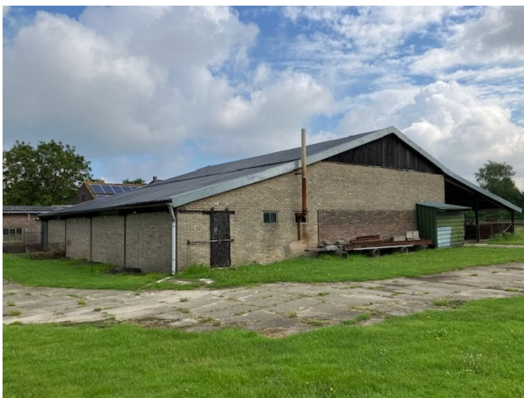
• Afbeelding 8: te slopen stal
