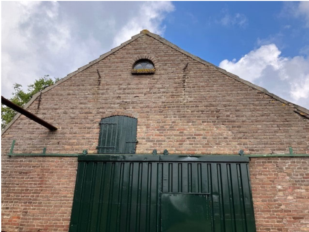
• Afbeelding 19: Achtergevel te behouden schuur
