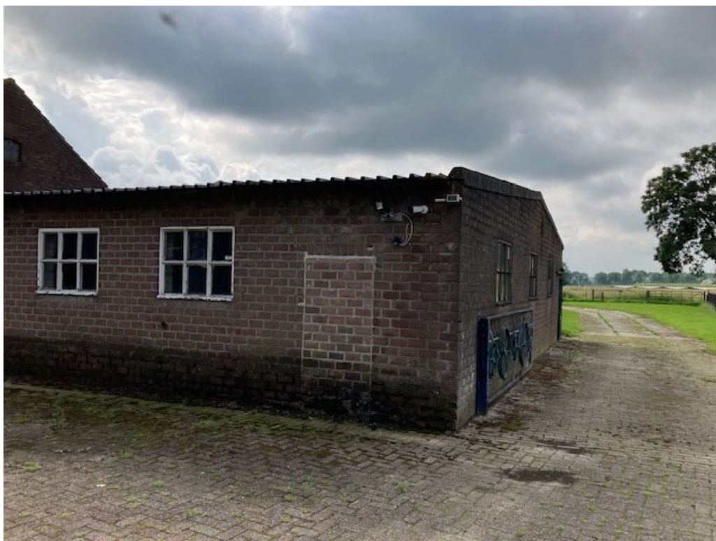
• Afbeelding 7: Te slopen bedrijfsgebouw, steens muur met ongeïsoleerde golfplaten
