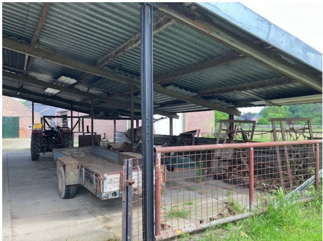
• Afbeelding 10: onderzijde schuur
