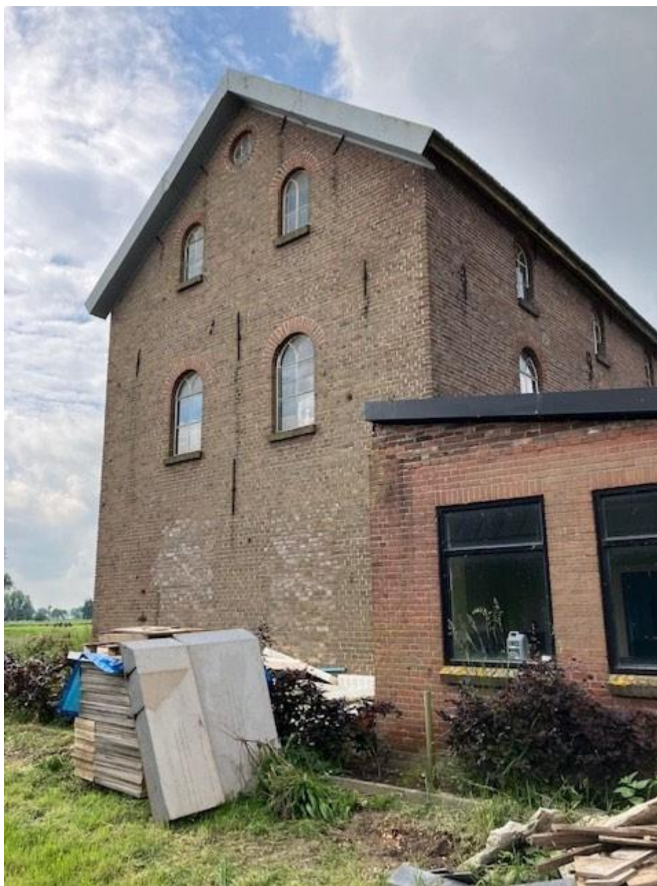
• Afbeelding 8: Linker zijgevel gemaal en de aanbouw die voor de voorgevel staat
