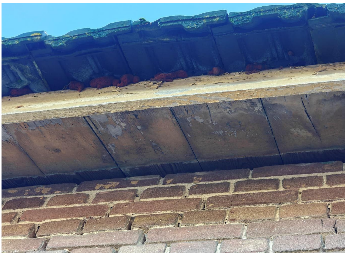
• Afbeelding 14: Gevel van het pand elke dakpan zit vastgepurd
