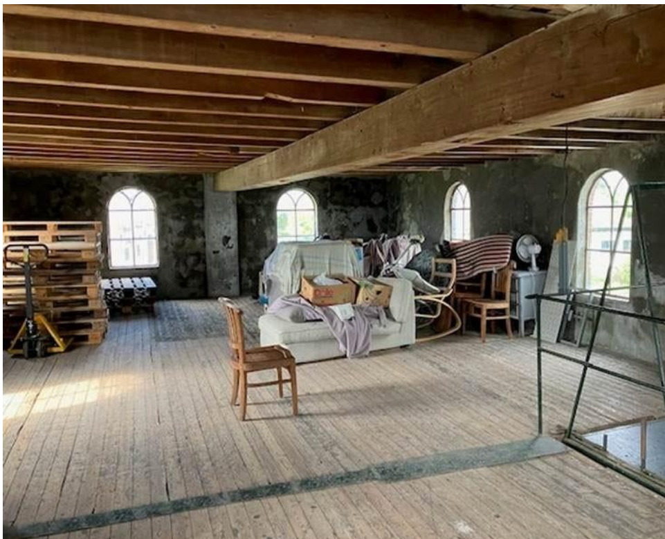
• Afbeelding 10: Middelste bouwlaag, houten balken plafond en balken vloer
