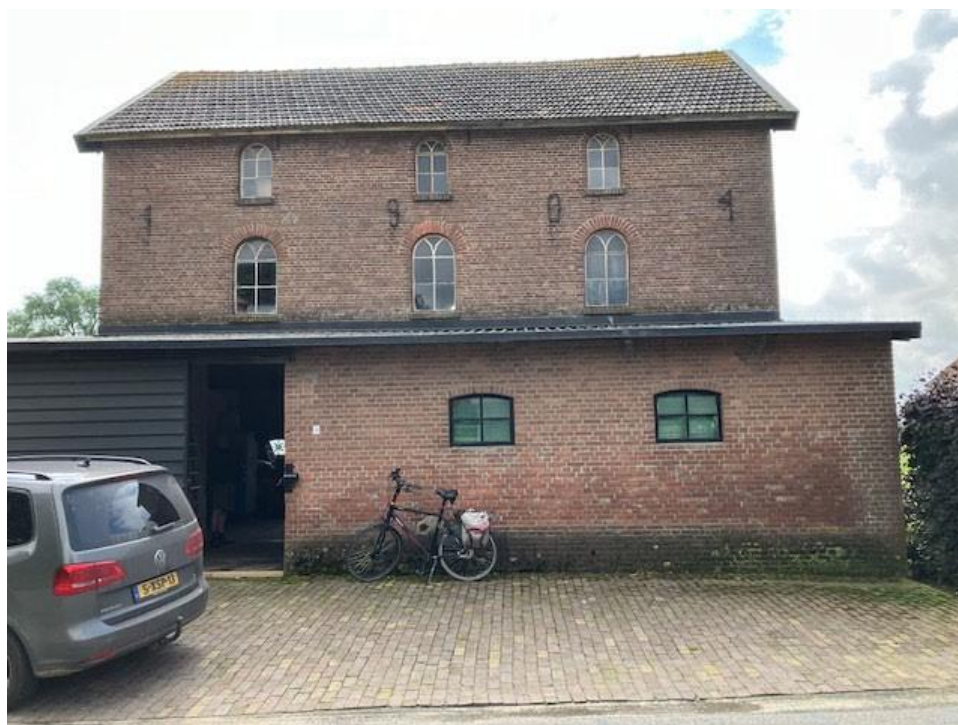
• Afbeelding 12: Voorgevel van het pand, aanbouw aan de voorzijde wordt gesloopt
