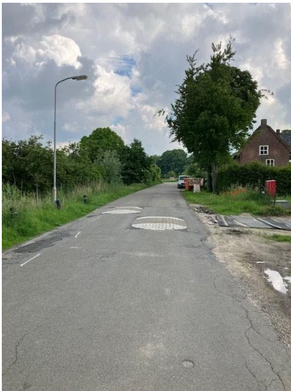
• Afbeelding 5: Straatbeeld in oostelijke richting
