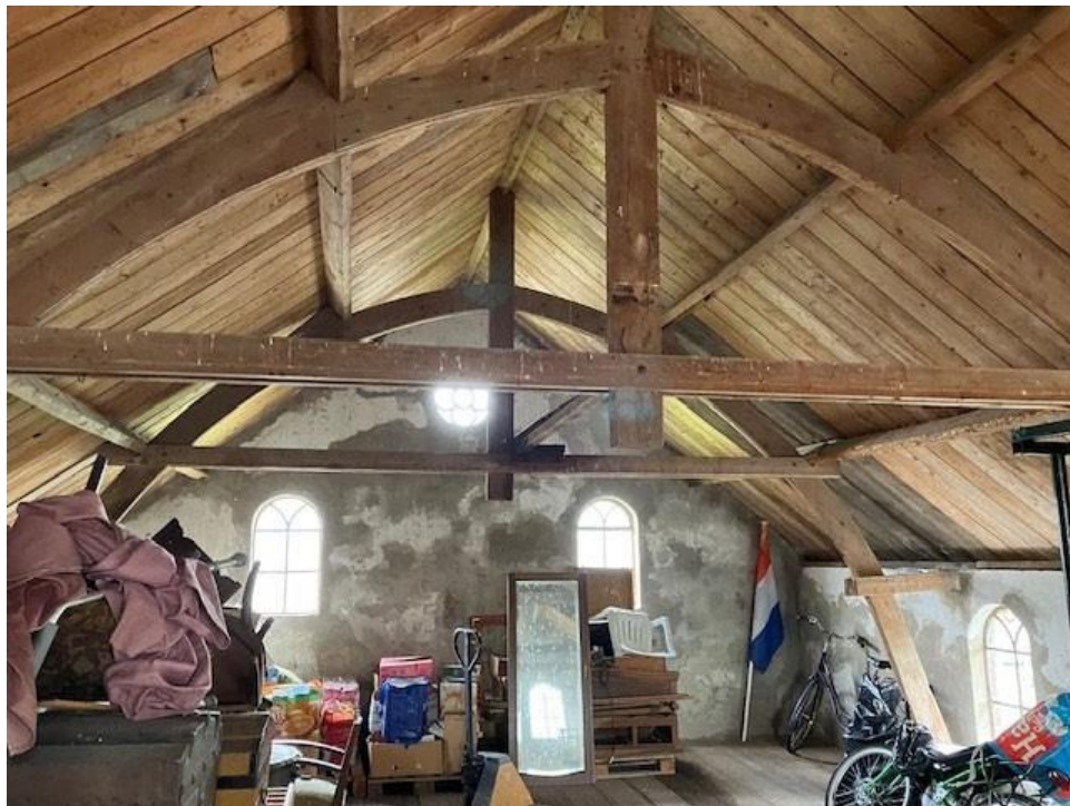
• Afbeelding 9: Zolderverdieping, zowel gebinten als dakbeschoot dateren uit 1904
