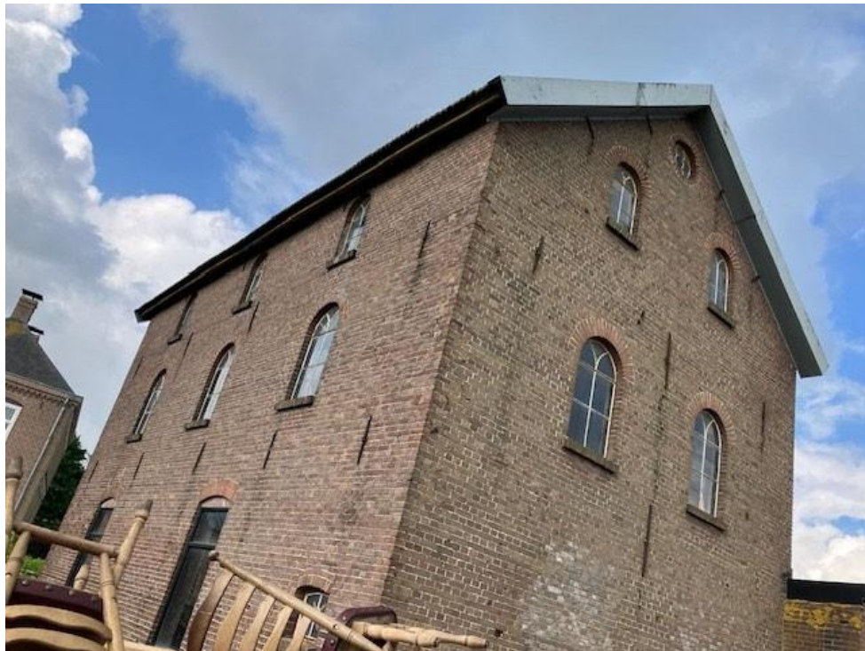
• Afbeelding 4: Achter- en zijgevel gemaal, op beide hoeken broed een huismus
