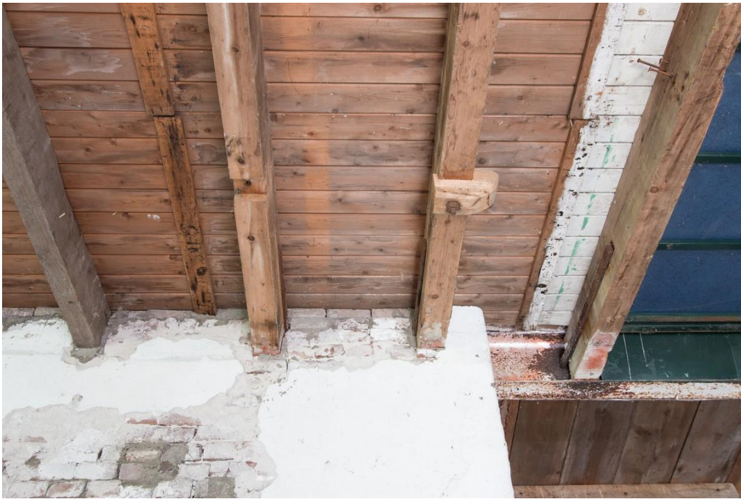
Eén van de weinige restanten van installatiewerk aan de binten uit 1904. Hier een restant van een dwarsbalkje dat met bouten aan twee binten was vastgezet. De precieze functie is niet duidelijk.
