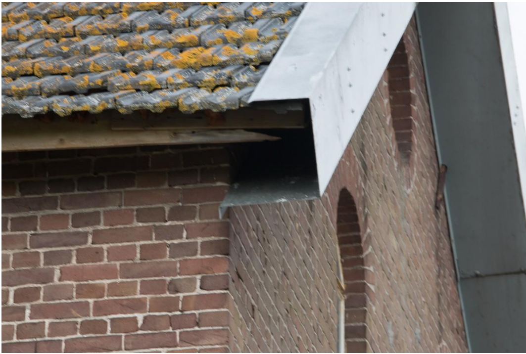
Detail van de windveer. De oorspronkelijke veel lijkt geheel verdwenen.
