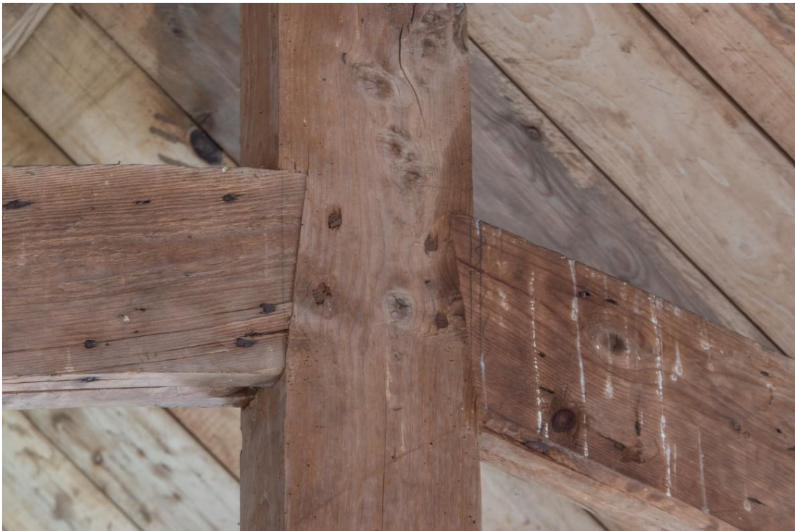
De aansluiting van de schenkels op de nokstijl. Potloodlijnen en toognagels.
