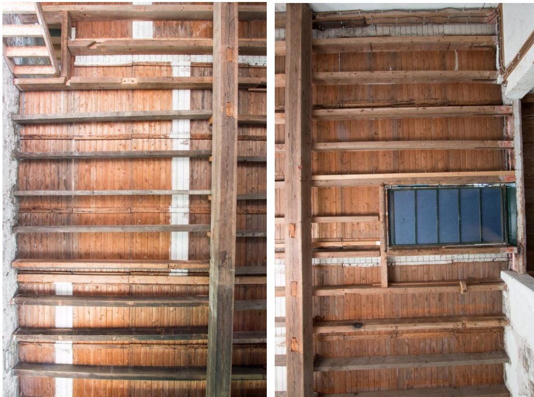
Opname van de vloerconstructie. De meeste van de niet doorgaande binten zijn van een verbouwfase. Op de rechter foto zien we het vergrote hijsgat. De raveelbalk is secundair en ingekast in een oorspronkelijke bint waarin sporen zijn te zien van een oudere raveelbalk.
