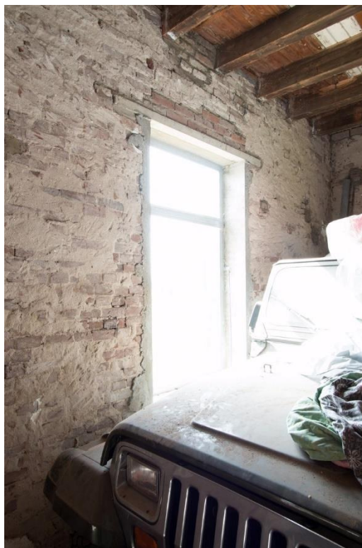
Eén van twee oorspronkelijke vensteropeningen in de voorgevel van het pand. Rechts detail van een oorspronkelijke vensteropening in de achtergevel. Latei en cementwerk van de dagkanten uit de tijd van het huidige venster.
