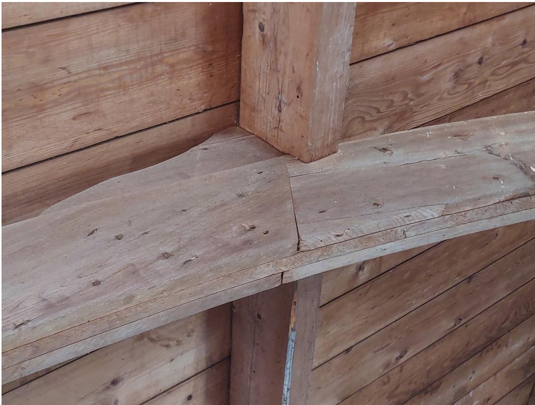
Detail met de gordingklos en stuiknaden van de schenkels.
