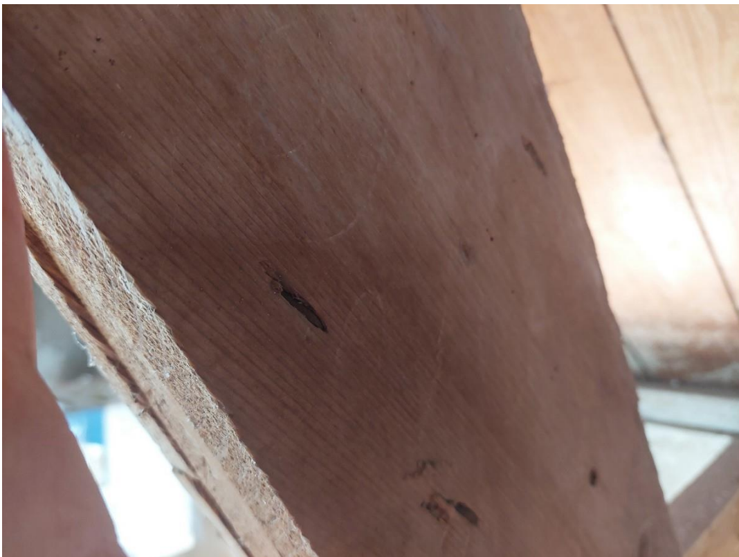
Detail met de omgeslagen nagels.
