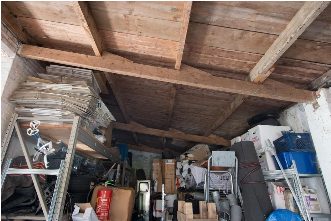
De kapconstructie is zeer eenvoudig. Delen van het beschot zijn hergebruikt.
