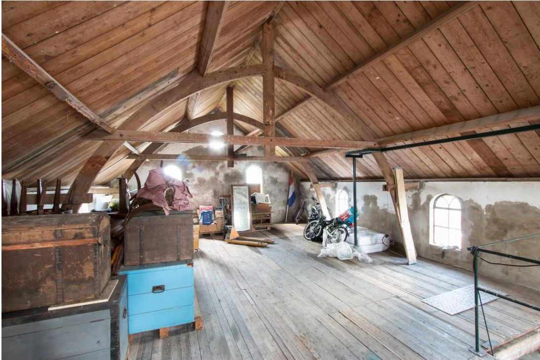
De zolderverdieping richting de rechter zijgevel gezien.
