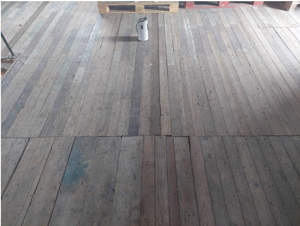
De vloer op de eerste verdieping is in het derde kwart van de vorige eeuw in de plaats gekomen van de oorspronkelijke vloer.
