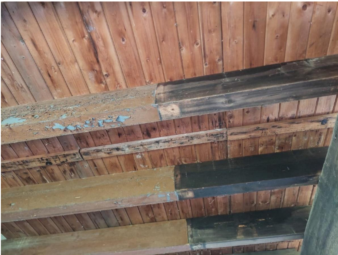
Aan de hand van gedeeltelijke schildering is de plaats van een verdwenen scheidingswand te herleiden. Die plaats correspondeert met sporen in de begane-grondvloer. Dat de kleur niet op de vloerdelen is te zien, bevestigt dat de vloerdelen in dit geval secundair zijn.
