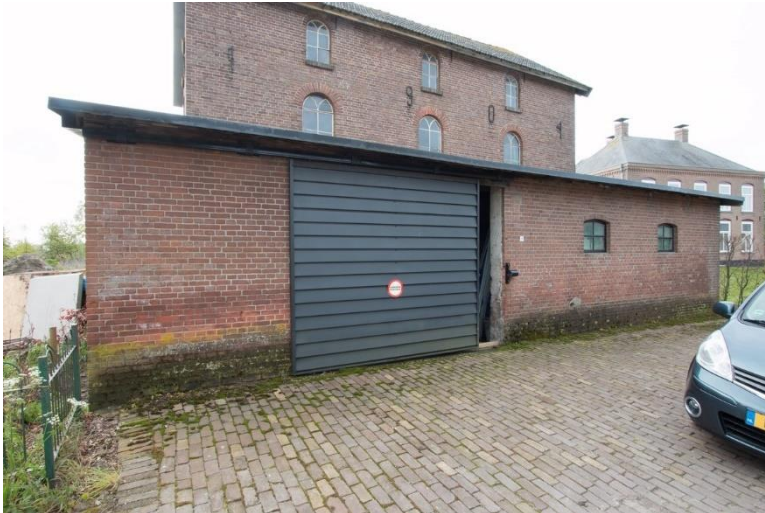
De voorgevel waarvan de gevelindeling, de ramen en de rail voor de schuifdeur nog uit de bouwtijd zijn. De deur zelf is van latere (vrij recente) datum.
