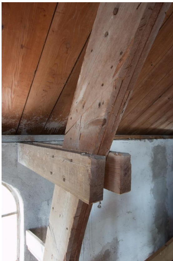
De dubbel uitgevoerde blokkeels en de stuiknaden van het Philibertspant. Rechts op de foto de opbouw van de spantbenen en de aansluiting van de trekbalken op de spantbenen.
