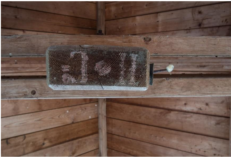
De onderkant van één van de nokstijlen met de initialen J.H. mogelijk van de timmerman. Rechts de opbouw van de schenkels.
