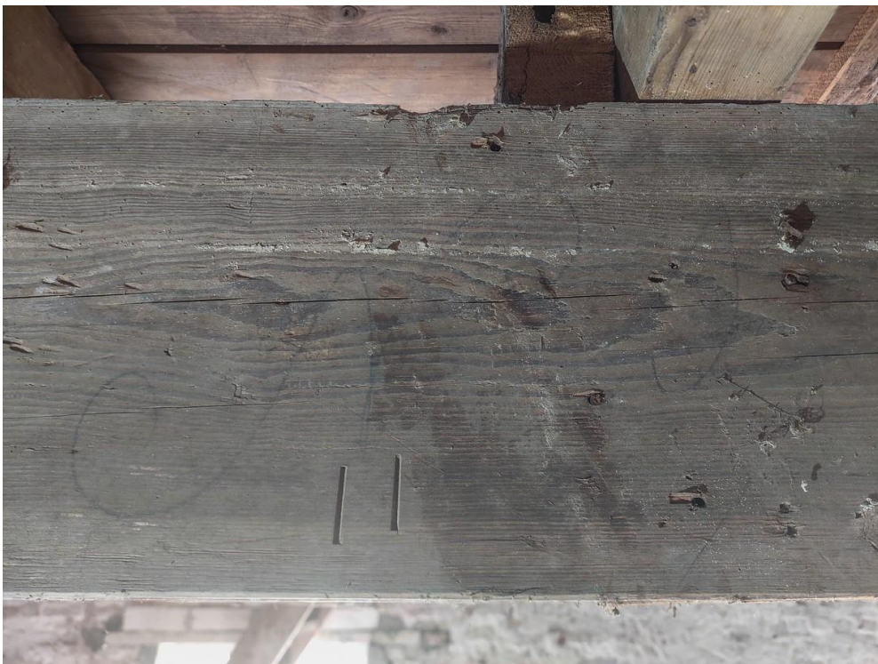
Waar het korbeel op de moerbalk aansloot, is het gehakte merk II aangebracht (voorgevelzijde) en is met potlood 'N2' geschreven.
