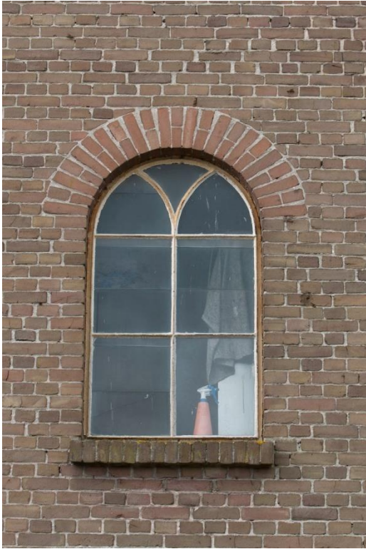
De vensters. Links de eerste verdieping en rechts de zolderverdieping (met in de boog smokkel-/passtenen).
