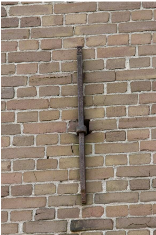
De balklaagankers in de gevel.
