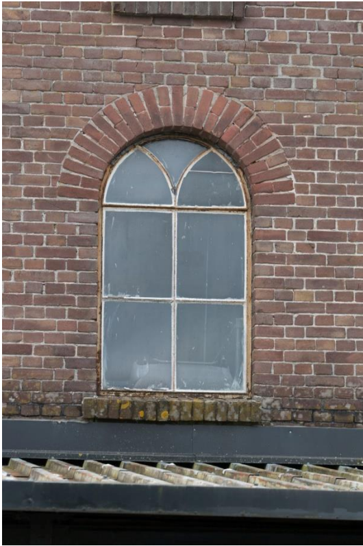
In detail de vensters op de eerste verdieping en op de zolderverdieping. De positie van de kaspanten is aangepast op de symmetrische indeling van de vensteropeningen (zie blokkeelanker).
