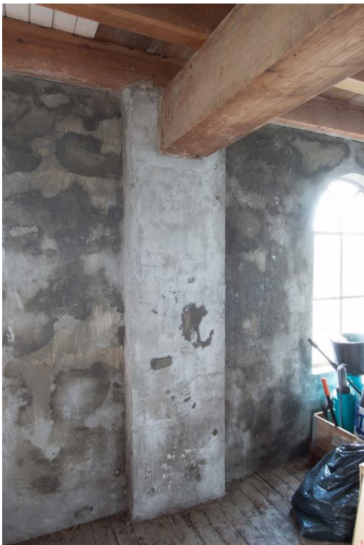
De zijgevel is een halve steen dunner op de verdieping. Ter plaatse van de oplegging van de moerbalk zijn derhalve in de bouwtijd penanten gemetseld.
