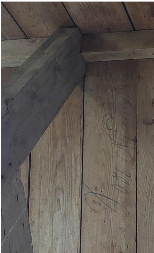
Delen van het dakbeschoot. Links het opschrift 'Voor Nijmegen' en rechts het opschrift 'niet weg'. De delen ogen oorspronkelijk, maar onomstotelijk staat de oorspronkelijkheid niet vast.
