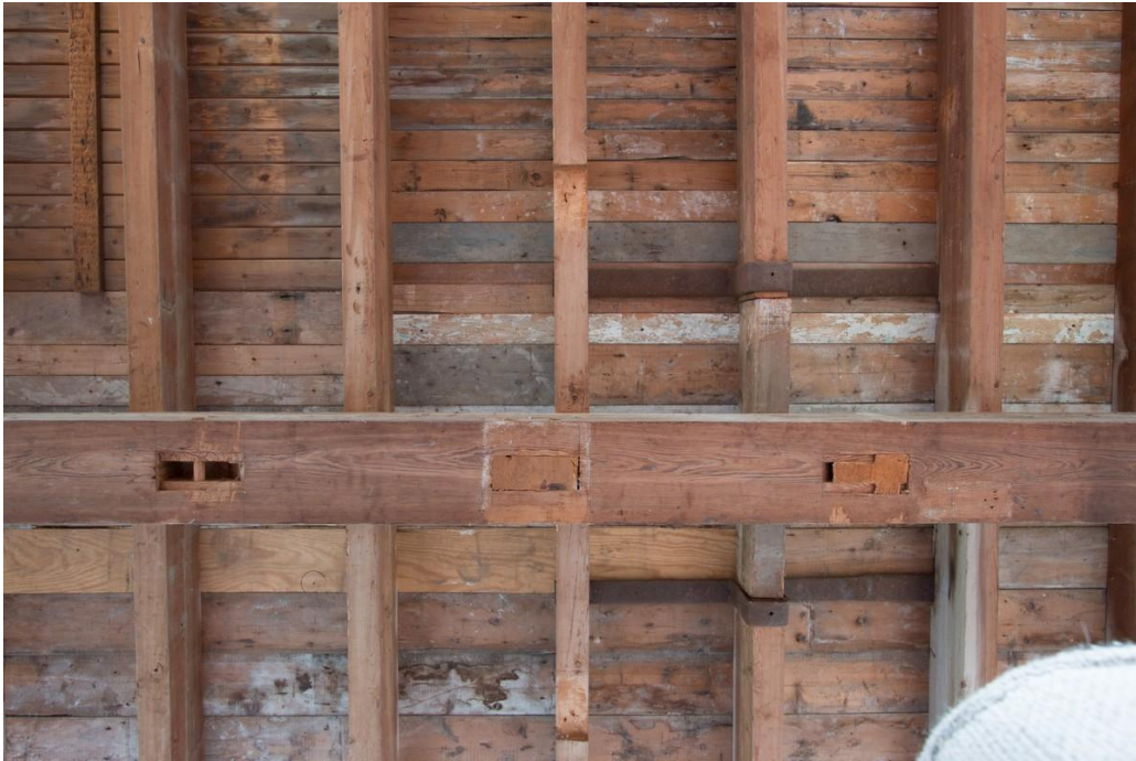
De aftekening van de verdwenen standvink in de vorm van afgehakte pengaten voor stijl (dimensies van de moerbalk) en de korbeels. De opname is gemaakt ter plaatse van de onderbroken bint (twee stipankers zijn te zien). Het deel tussen de ankers is secundair. De voormalige vloeropening is in de vloerdelen niet te zien. De vloerdelen zijn dus secundair.
