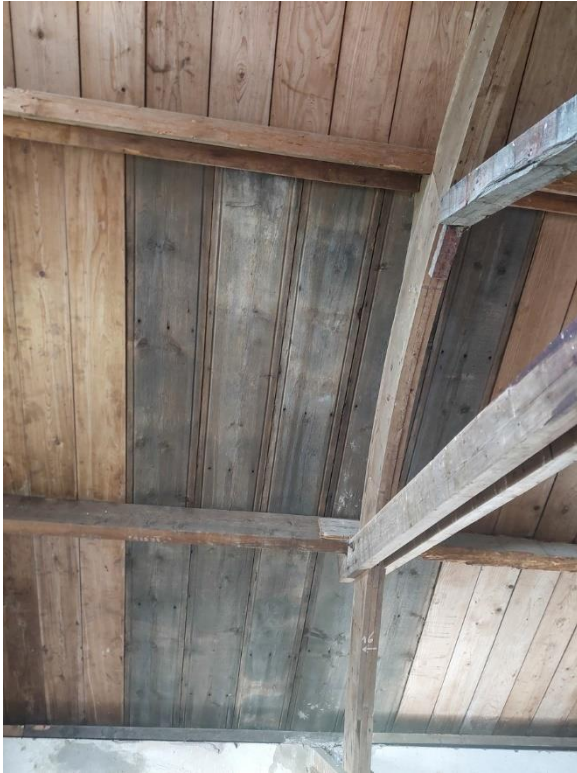
Delen van het dakbeschot zijn vernieuwd, wat onder andere te zien is aan soortgelijke gegroefde delen als aangetroffen in stukken van de aantoonbaar vernieuwde zoldervloer.
