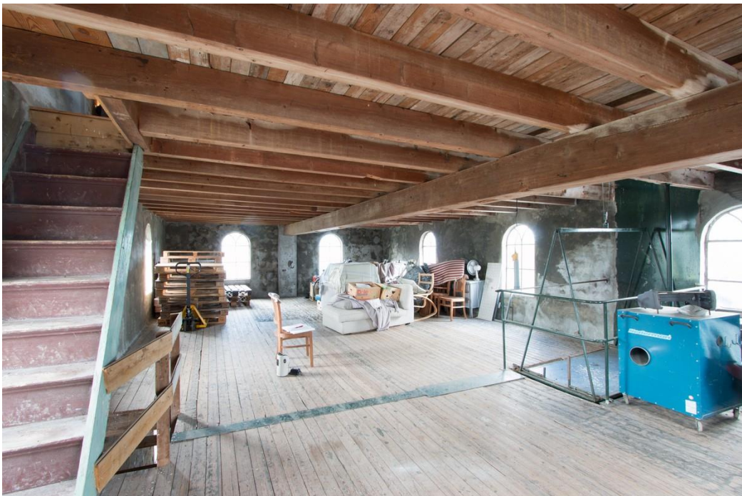
De eerste verdieping in de richting van de rechter zijgevel en de voorgevel.
