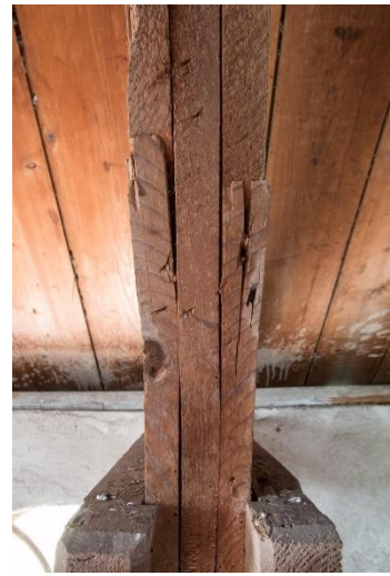
De onderkant van één van de nokstijlen met de initialen J.H. mogelijk van de timmerman. Rechts de opbouw van de schenkels.
