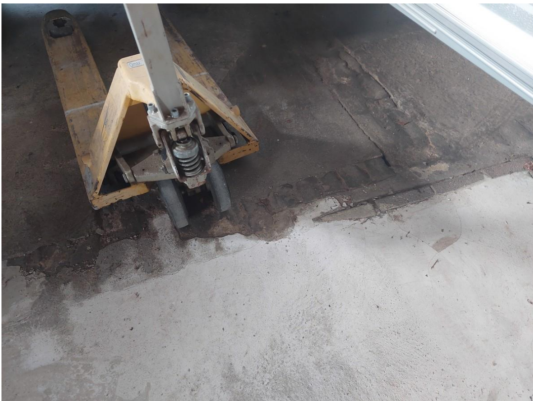
Meer in detail de aftekening van de verdwenen scheidingsmuren. De aftekening is ook te herkennen op de balken van de verdiepingsvloer.
