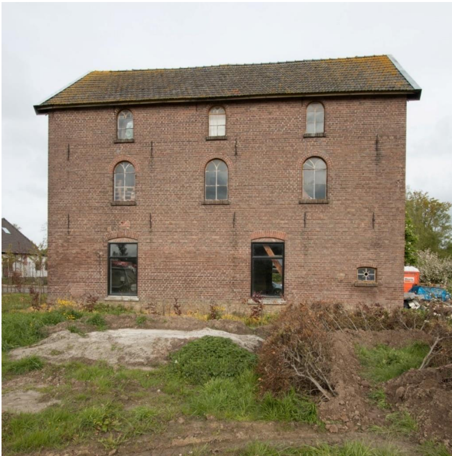
De achtergevel waarin de grootste aanpassing in de tijd het vervangen van twee vensters op de begane grond is. De dakbedekking zal ook zijn vernieuwd (zoals bij de beschrijving van de voorgevel al is gesuggereerd).
