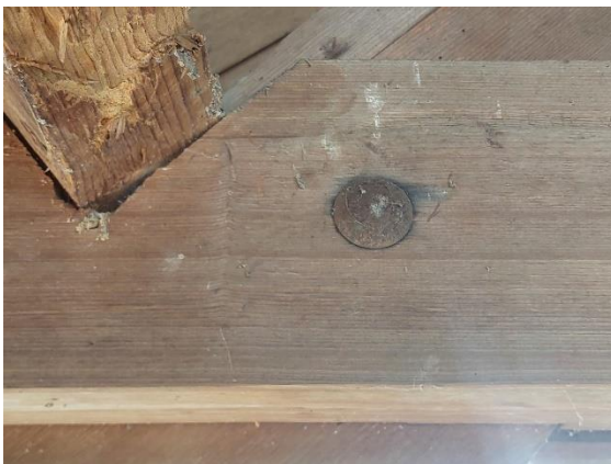
De bout en moer (met ring) van de trekbalen.
