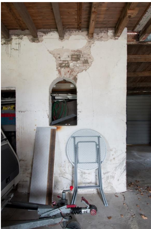
Eén van twee oorspronkelijke vensteropeningen in de voorgevel van het pand. Rechts detail van een oorspronkelijke vensteropening in de achtergevel. Latei en cementwerk van de dagkanten uit de tijd van het huidige venster.
