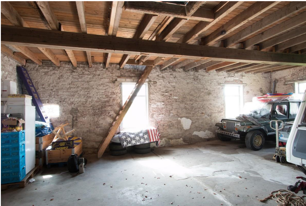
Opname in de richting van de achtergevel, ontdaan van pleisterwerk. Secundaire lateien boven de vensteropeningen in beeld. De trap (en het trapgat) is uit de jaren 1944-1950.
