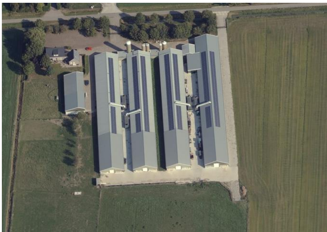
• Figuur 2.1: uitsnede luchtfoto ter plaatse van Zwaanheuvelstraat 8 (bron: Cyclomedia)
