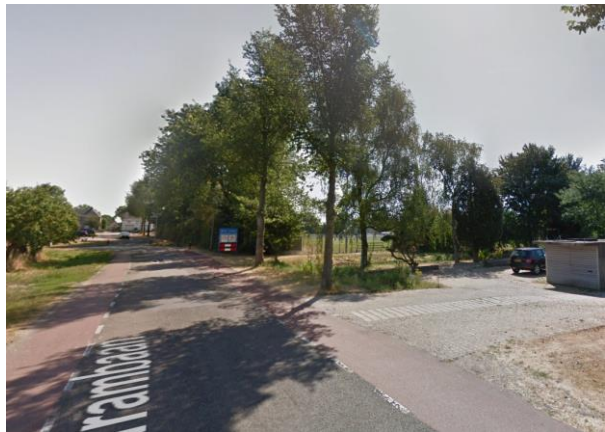
Trambaan in oostelijke richting (google maps)
