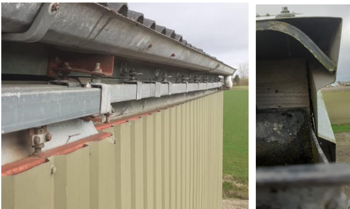
Figuur 7: ruimte onder dak- en gootconstructie
