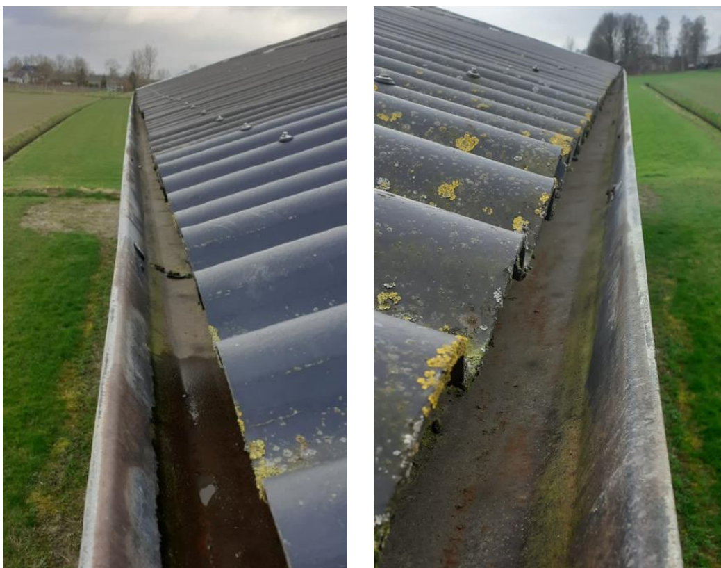
Figuur 6: dakgootconstructie oost- en westgevel.
