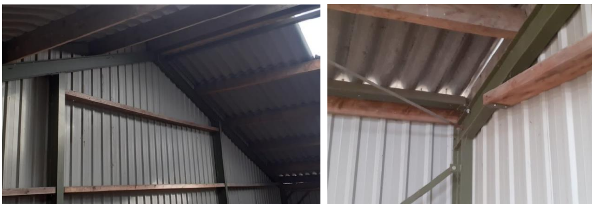
Figuur 8: binnenzijde loodsconstructie
