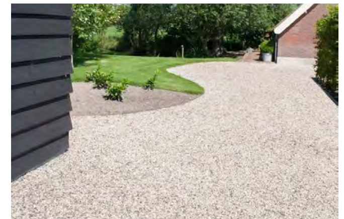
Verharding bestaat uit halfverharding ten behoeve van regenwaterinfiltratie
