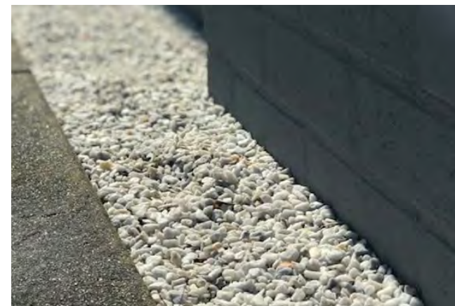
Een grindkoffer / -strook is ook een goede oplossing voor regenwaterinfiltratie
