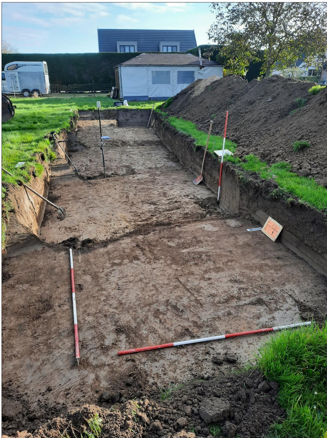
Figuur 3. Overzichtsfoto werkput 1. Opnamerichting: zuiden.
