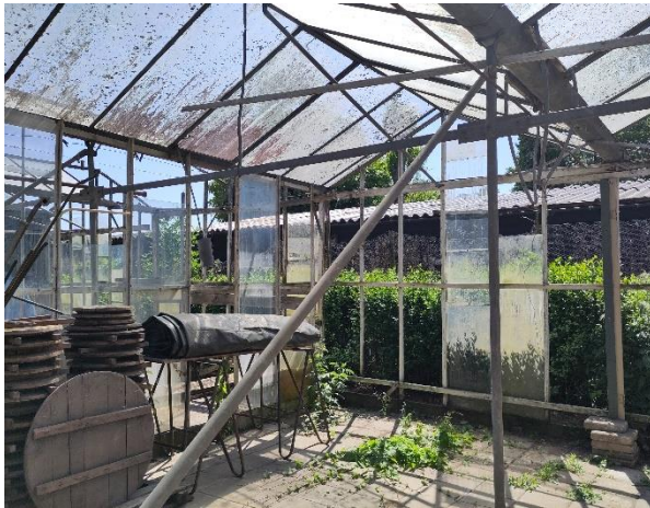
Afbeelding 3. Indruk van het plangebied met linksboven de heder, rechtsboven een deel van de moestuin. Links- en rechtsonder is de slechte staat van de kas te zien door ontbrekend glas en rot hout.
