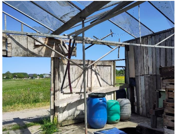
Afbeelding 3. Indruk van het plangebied met linksboven de heder, rechtsboven een deel van de moestuin. Links- en rechtsonder is de slechte staat van de kas te zien door ontbrekend glas en rot hout.
