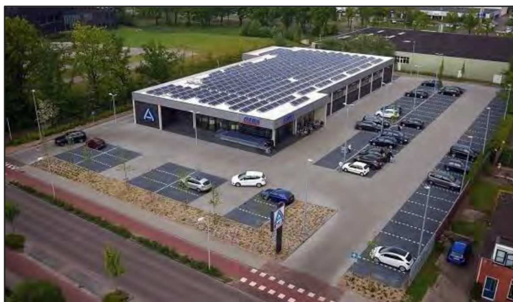
Figuur 1.2: Impressie luchtfoto nieuwe supermarkt (Bron: Aldi)
