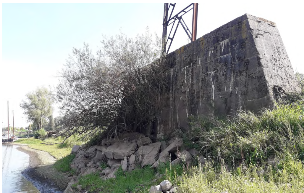
Figuur 3.3: impressiefoto van het plangebied. Zicht op het fundament van de kraanbaan.
