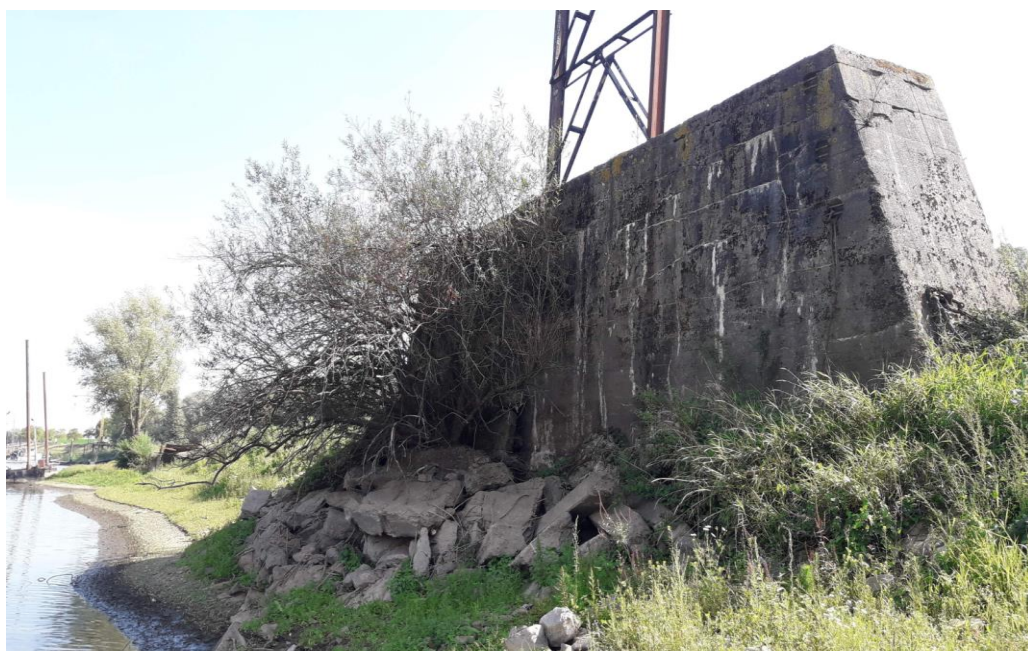
Figuur 5: impressiefoto van het plangebied. Zicht op het fundament van de kraanbaan.
