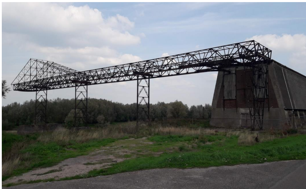
Figuur 4: Overzichtsfoto van de kraanbaan en het silogebouw binnen het plangebied.
