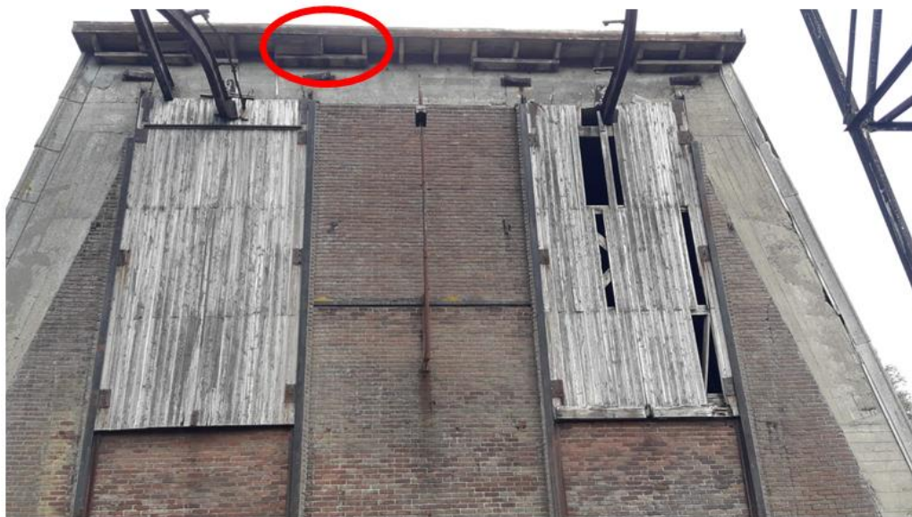
Figuur 11: Voorzijde van het silogebouw met openingen en schotten die mogelijk geschikt zijn voor vogels met jaarrond beschermde nesten als gierzwaluw, kerkuil en steenuil. De rode cirkel geeft aan waar nestmateriaal is aangetroffen.
