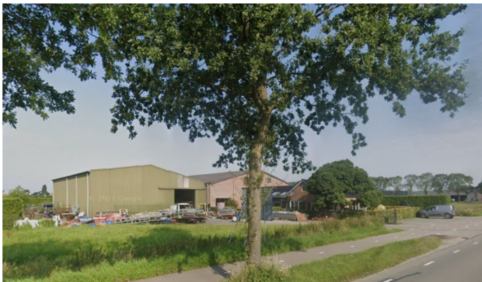
Bestaande bedrijfslocatie aan de Veesteeg 16 aan de noordzijde van het plangebied
